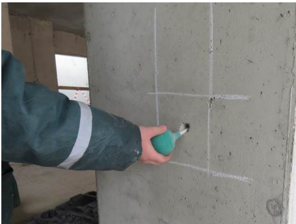
Рис. 4.2.6. Продувка отверстия от пыли в монолитном железобетонном пилоне подвального этажа в осях 12/1/А/1-Б/1
