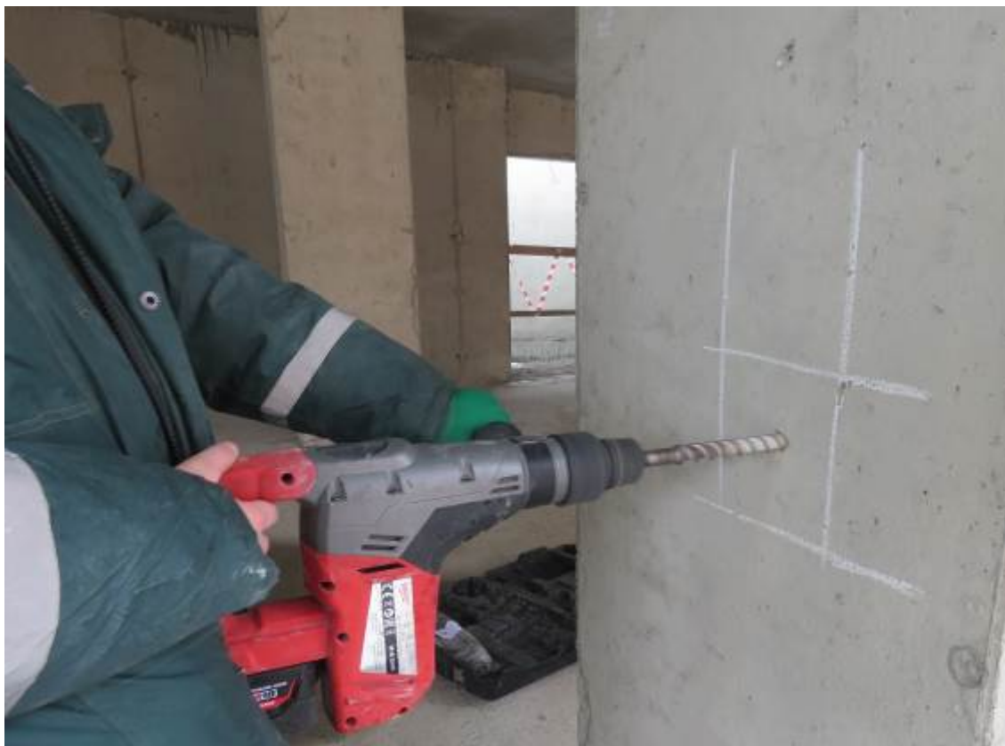
Рис. 4.2.5. Сверление отверстия в монолитном железобетонном пилоне четвертого этажа в осях 12/1/А/1-Б/1
