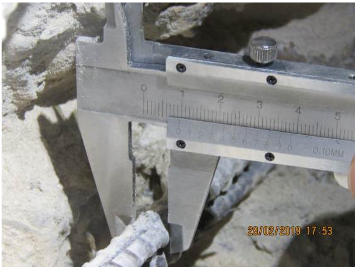
Рис. 3.2.18. Замер диаметра горизонтальных арматурных стержней в монолитной стене подвального этажа в осях 2/2/Б/2-В/2
