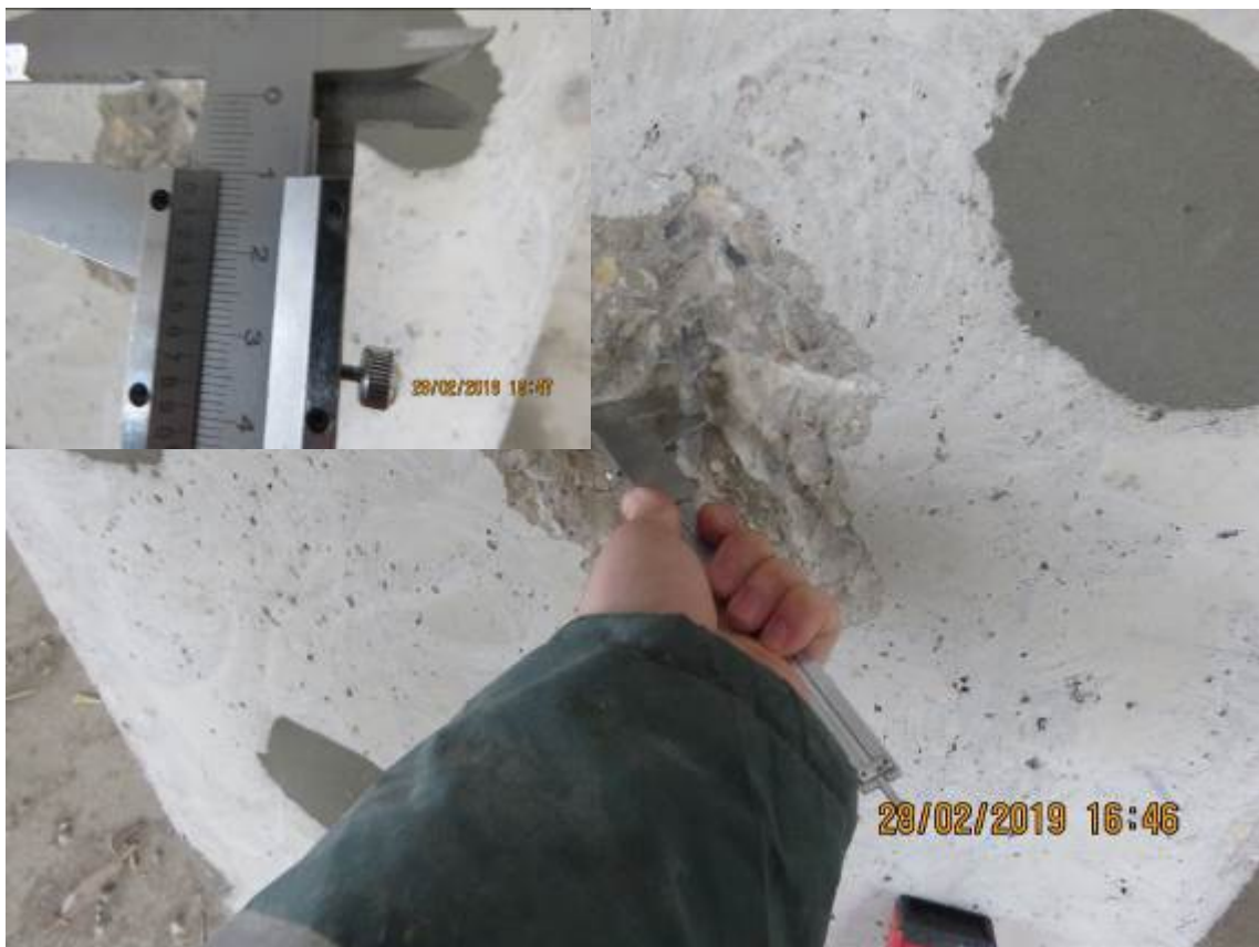
Рис. 3.2.12. Замер диаметра вертикального арматурного стержня в монолитном пилоне первого этажа в осях 6/2/Д/2
