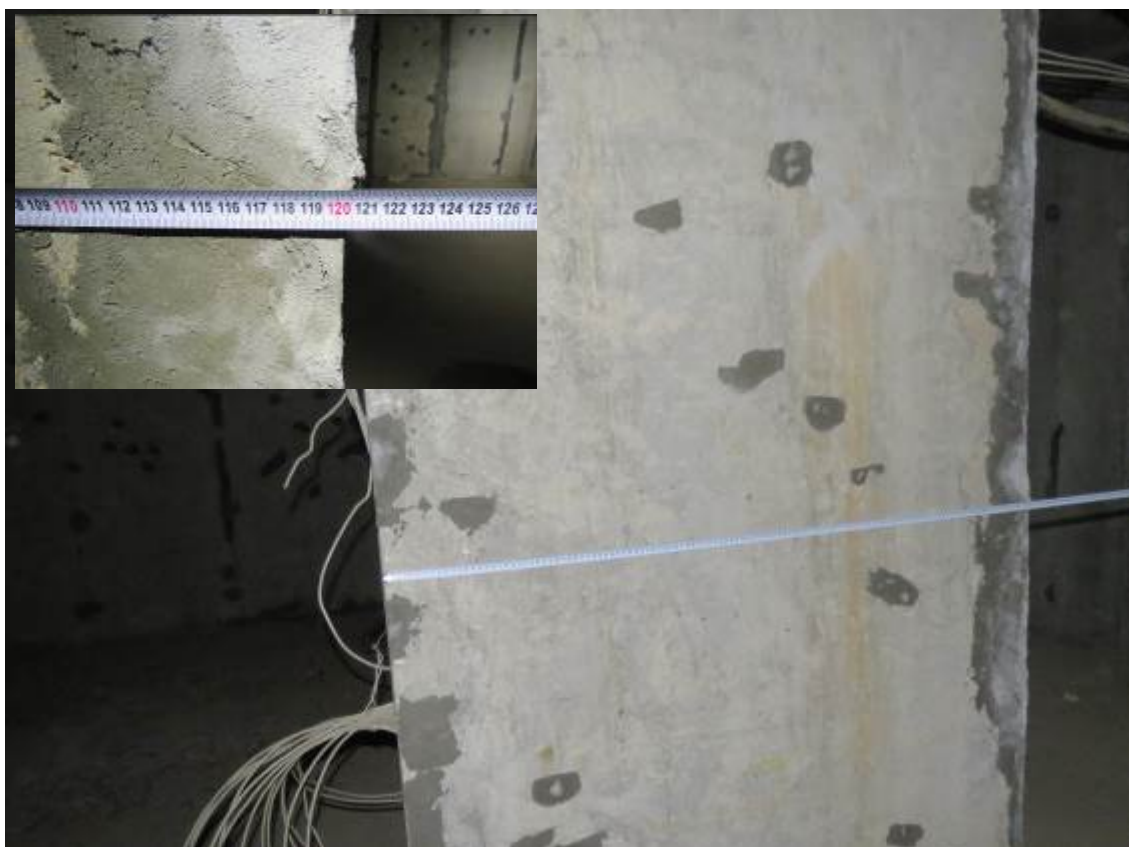
Рис. 2.2. Замер сечение монолитного железобетонного пилона подвального этажа (1200×200 мм)
