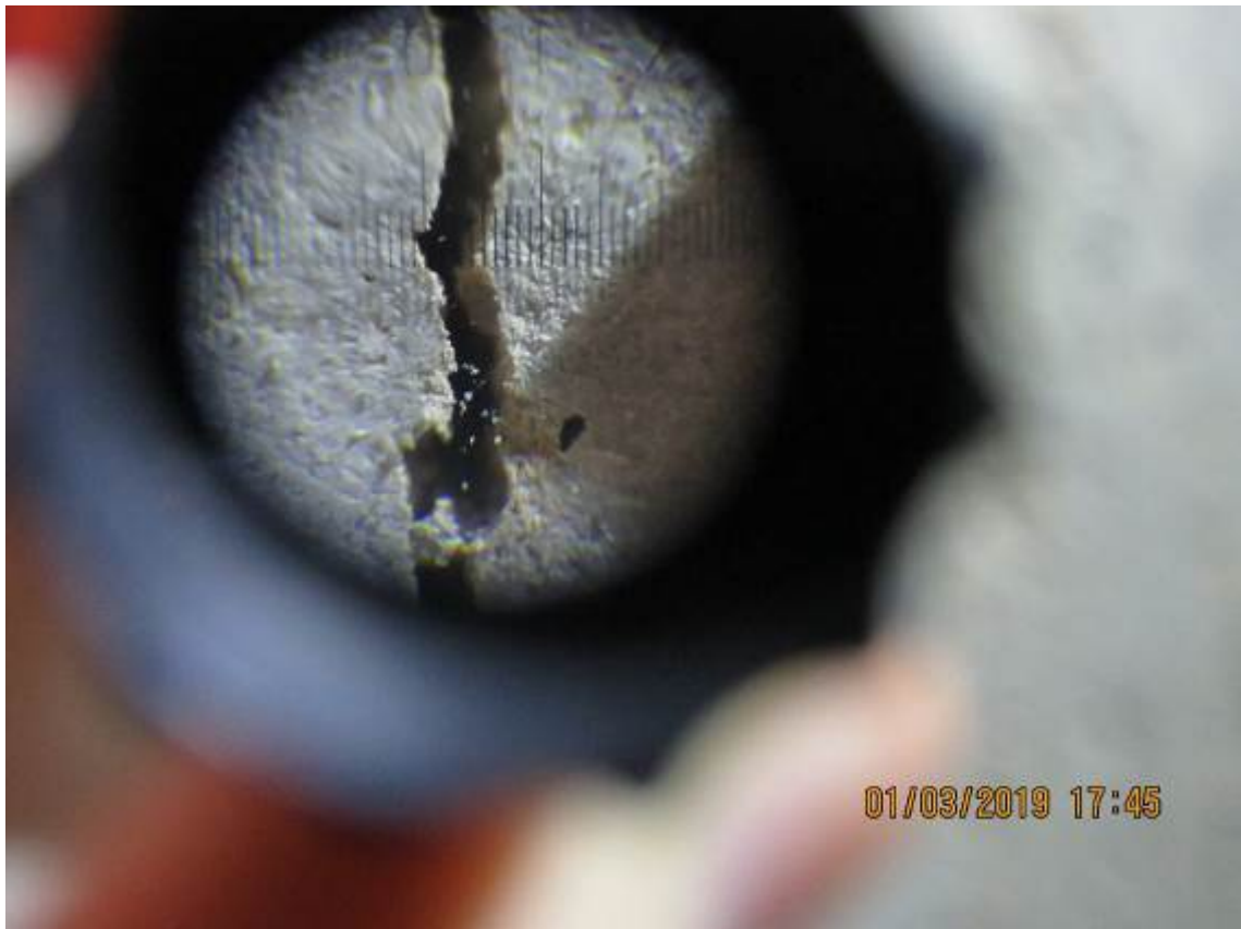
Рис.3.2.22. Вертикальные трещины в монолитных стенах
