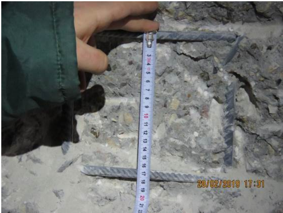
Рис. 3.2.15. Замер шага горизонтальных арматурных стержней в монолитной стене третьего этажа в осях 12/1-13/1/Г/1
