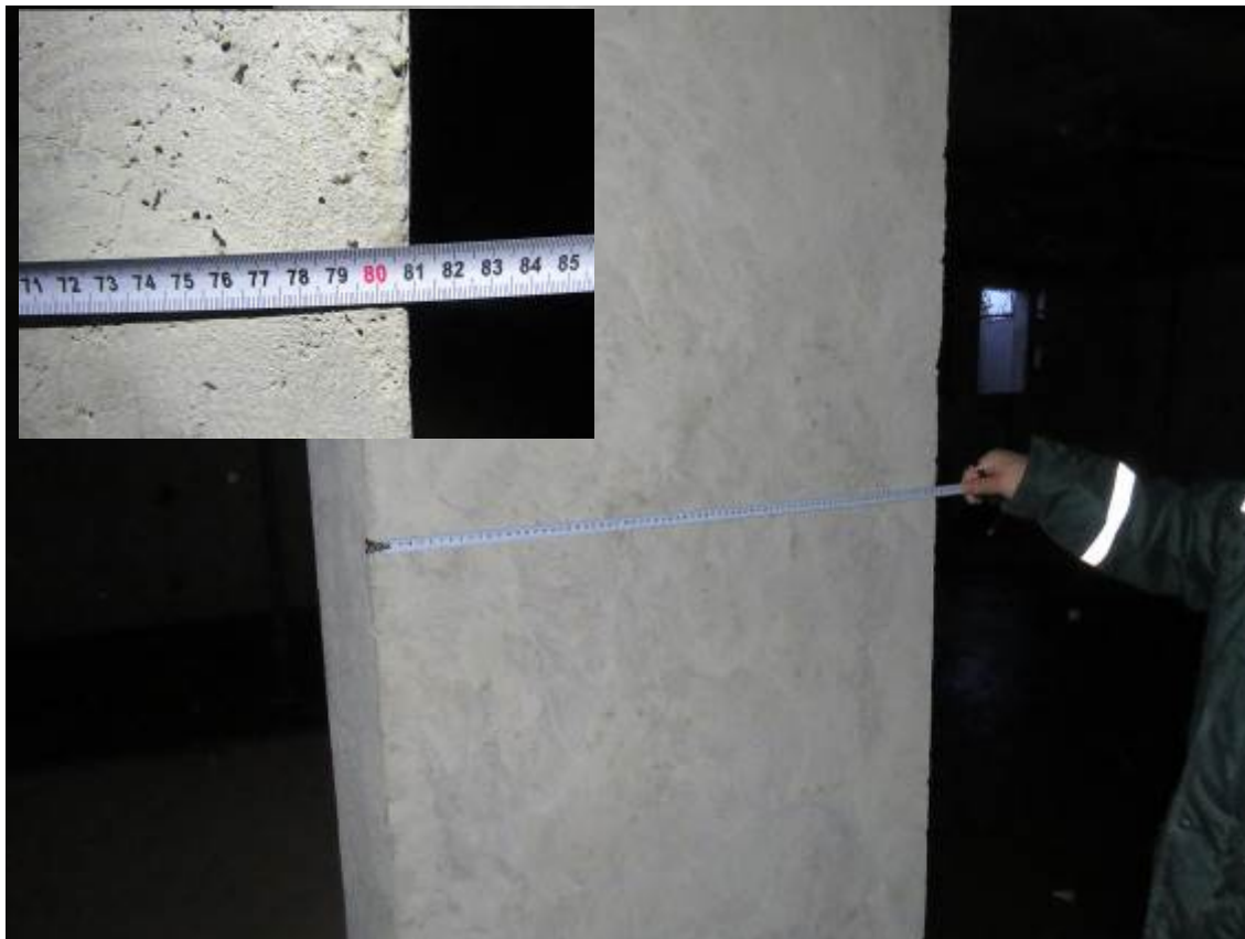
Рис. 2.1. Замер сечение монолитного железобетонного пилона подвального этажа (800×200 мм)
