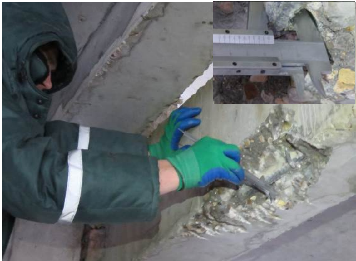
Рис. 3.3.12. Замер диаметра продольного арматурного стержня монолитной балки в осях 29/2-30/2/Ш/3
