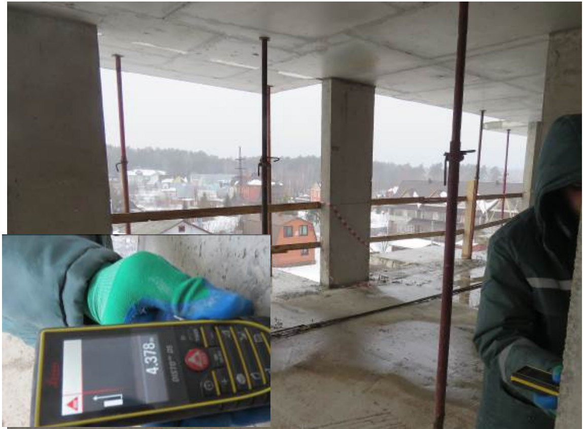
Рис. 2.5. Замер расстояния между пилонами четвёртого этажа в чистоте
