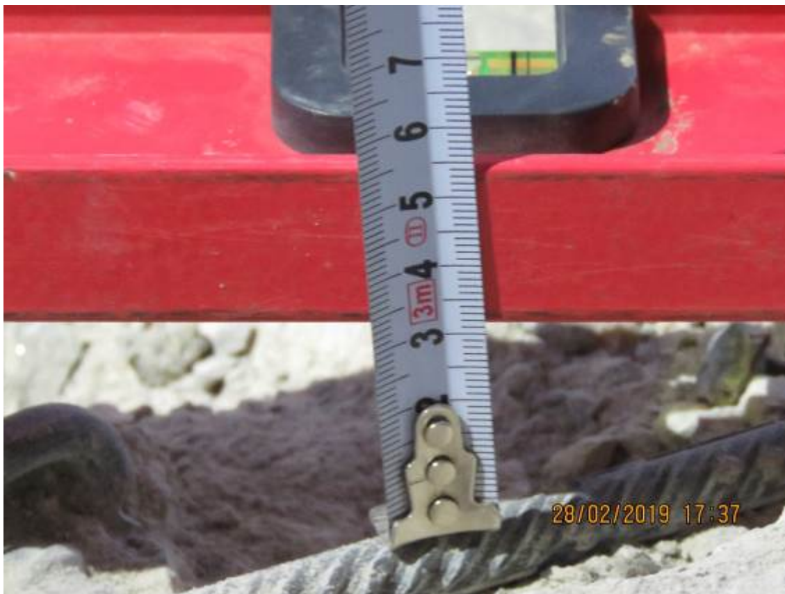
Рис. 3.3.7. Замер защитного слоя бетона плиты перекрытия второго этажа в осях 15/1-16/1/А/1
