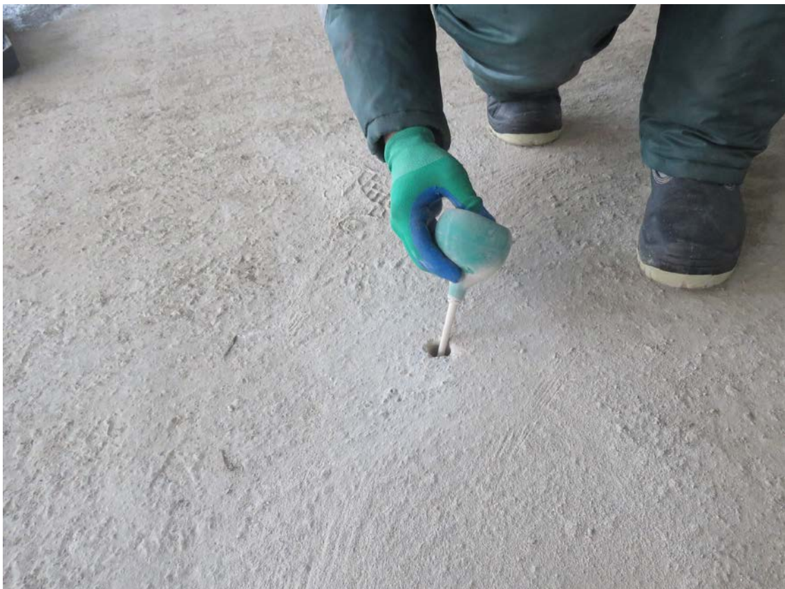
Рис. 4.2.10. Продувка отверстия от пыли в монолитной железобетонной плите перекрытия третьего этажа в осях 12/1-14/1/А/1-Б/1
