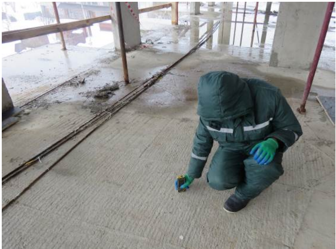
Рис. 2.8. Замер высоты четвёртого этажа секции № 1 в чистоте
