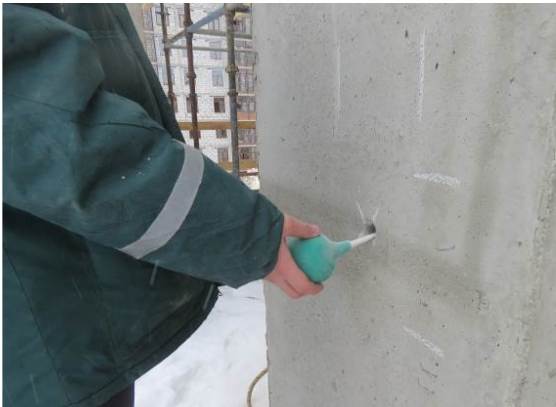
Рис. 4.2.2 . Продувка отверстия от пыли в монолитном железобетонном пилоне третьего этажа в осях 29/2-30/2/В/4
