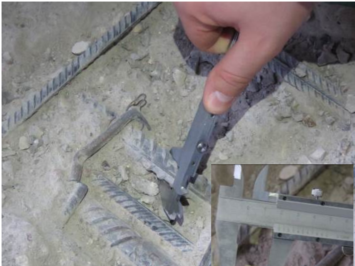
Рис. 3.3.6. Замер диаметра дополнительного верхнего армирования плиты перекрытия второго этажа в осях 15/1-16/1/А/1
