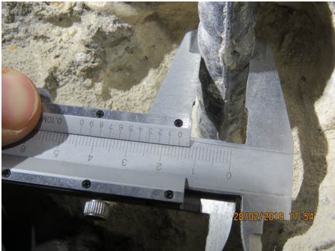
Рис. 3.2.11. Замер диаметра вертикального арматурного стержня в монолитном пилоне подвального этажа в осях 4/2/Б/2-В/2
