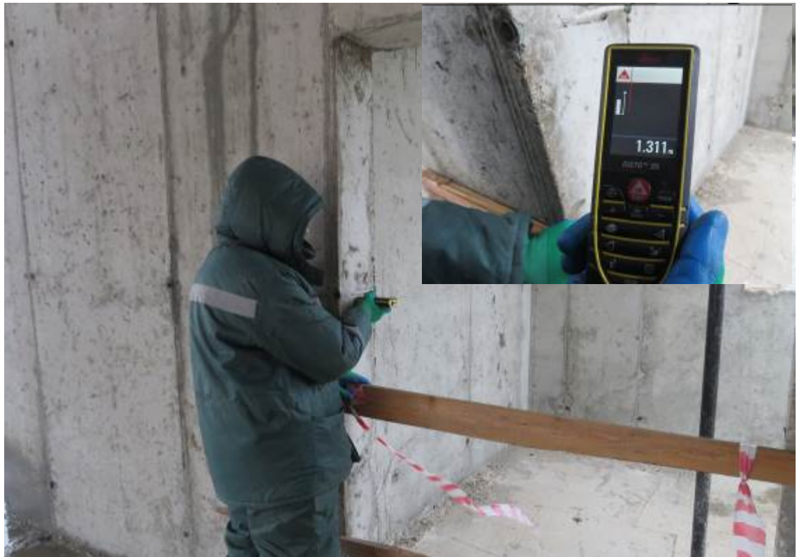
Рис. 2.6. Замер геометрических параметров дверного проёма лестничной клетки четвёртого этажа
