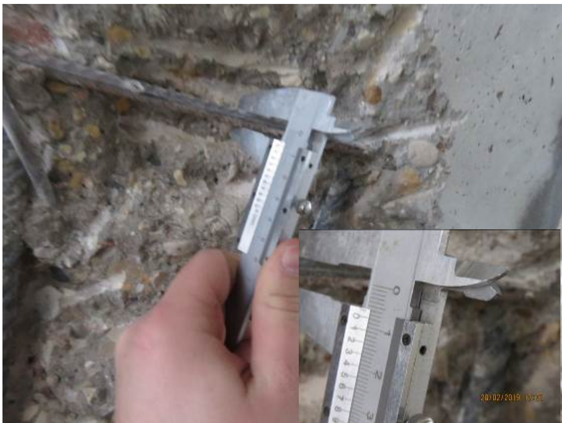
Рис. 3.2.8. Замер диаметра горизонтального арматурного стержня в монолитном пилоне первого этажа в осях 29/2-30/2/Г/4
