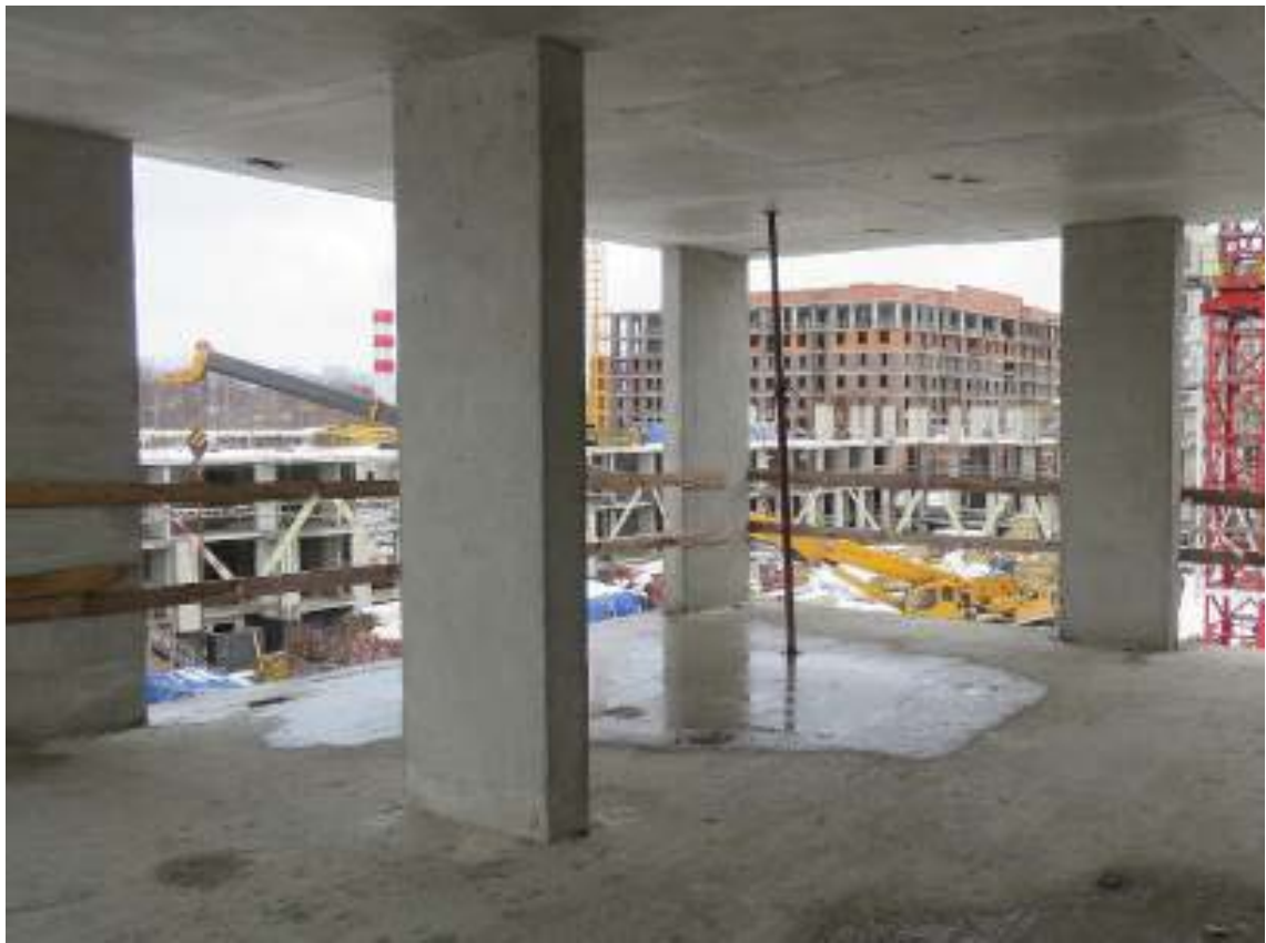
Рис. 3.2.1. Общий вид вертикальных несущих конструкций четвёртого этажа
