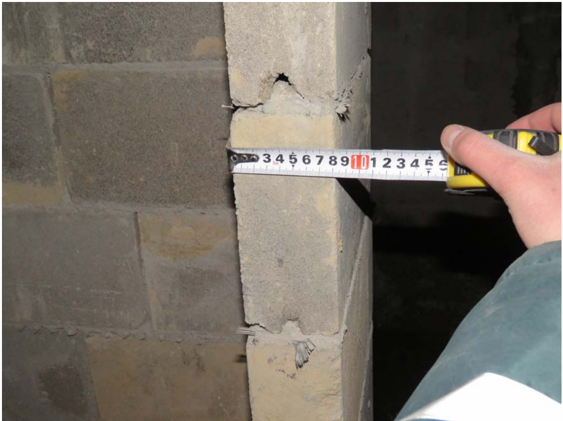
Рис.3.4.1. (а, б, в) Замер геометрических параметров керамзитобетонного блока
