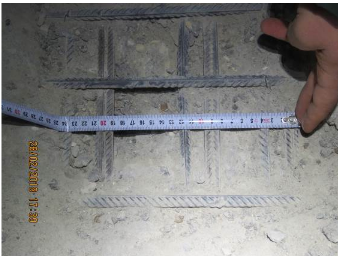
Рис. 3.3.8. Замер шага верхнего армирования плиты перекрытия второго этажа в осях 17/Г/Г/1-Д/1
