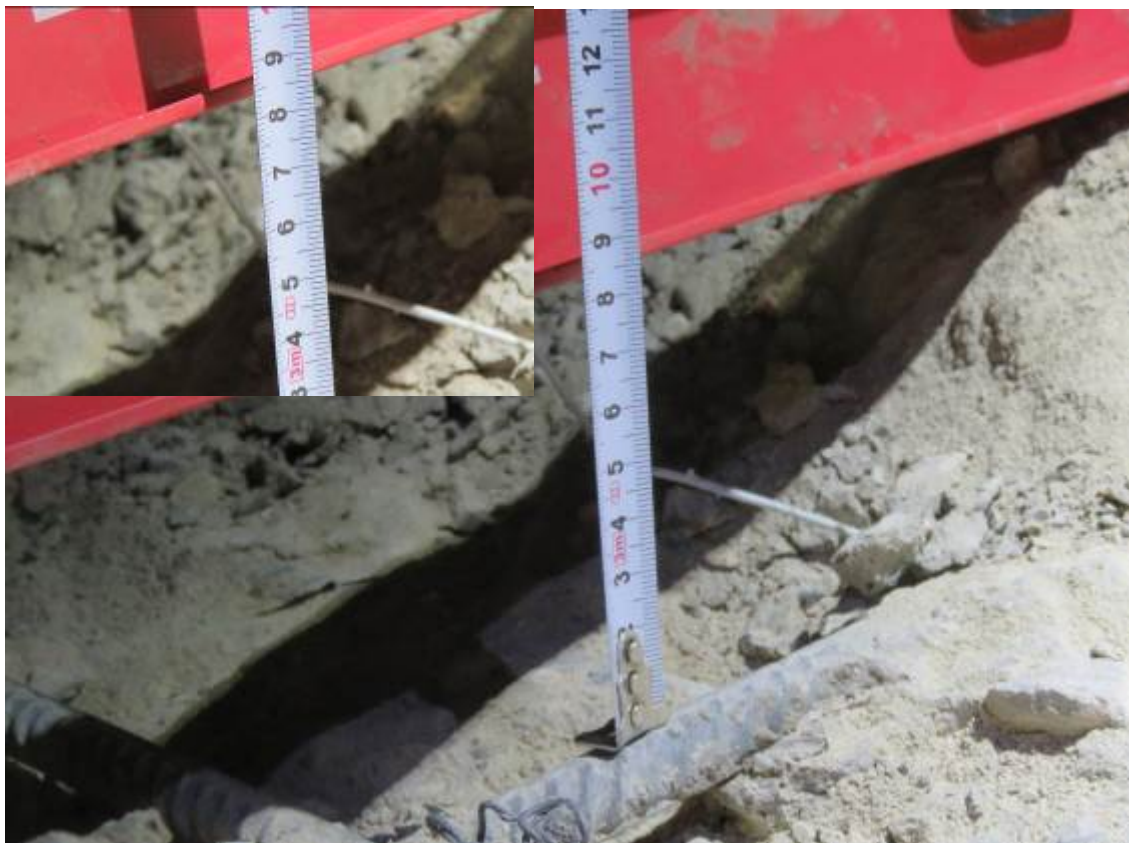
Рис. 3.1.9. Замер защитного слоя бетона фундаментной плиты в осях 11/2-12/2/Л/2-М/2
