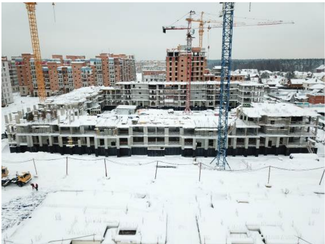
Рис. 1.2. Общий вид обследуемого здания с севера
