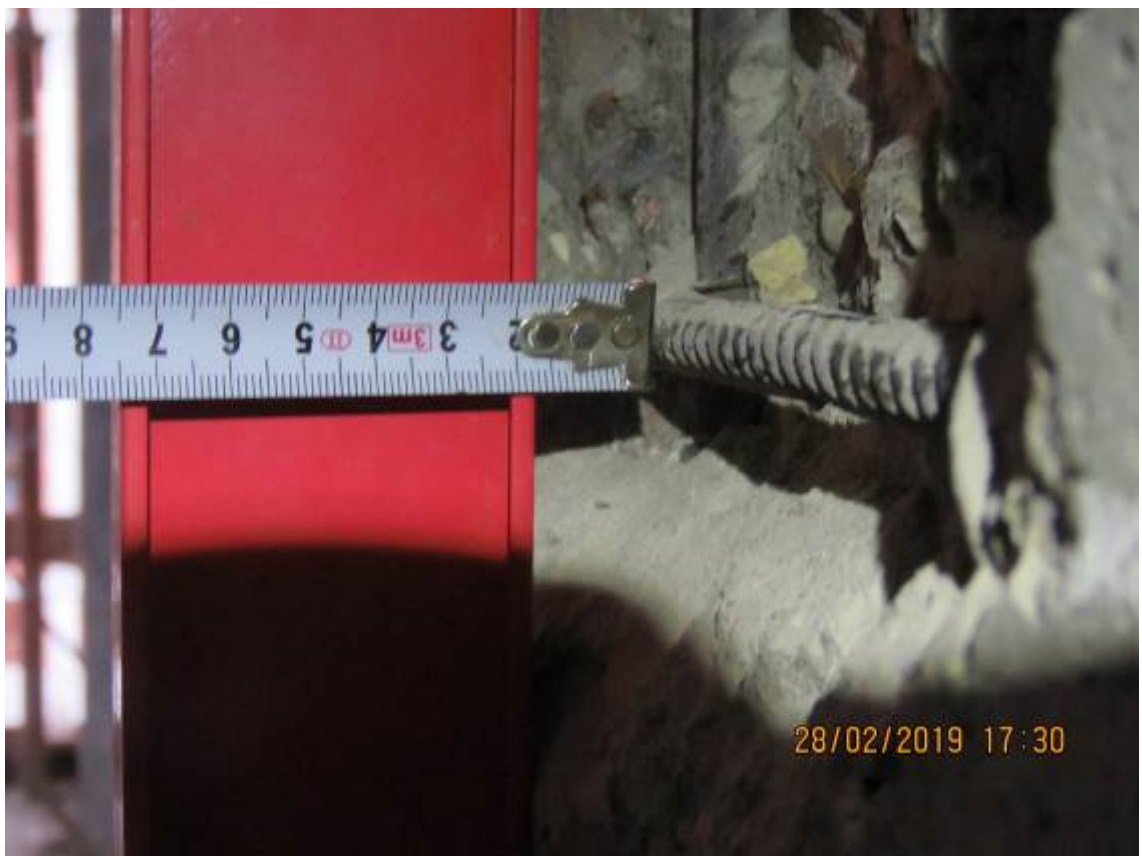
Рис. 3.2.10. Замер защитного слоя бетона монолитного пилона в осях 11/1/Б/1
