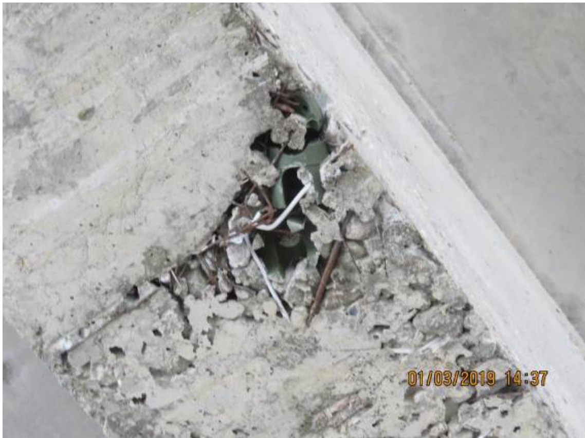
Рис.3.3.18. Посторонние включения в монолитных балках
