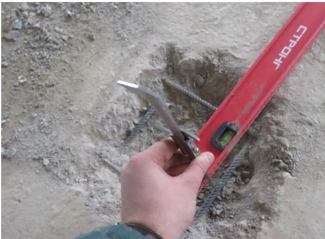
Рис. 3.3.4. Замер защитного слоя бетона плиты перекрытия подвального этажа в осях 29/2-30/2/А/5-Б/5
