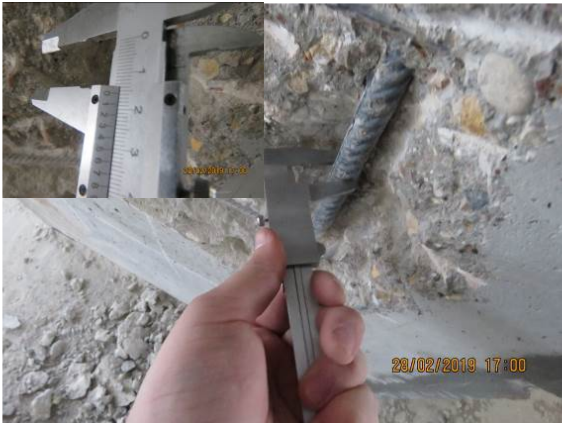
Рис. 3.2.7. Замер диаметра вертикального арматурного стержня в монолитном пилоне первого этажа в осях 29/2-30/2/Г/4
