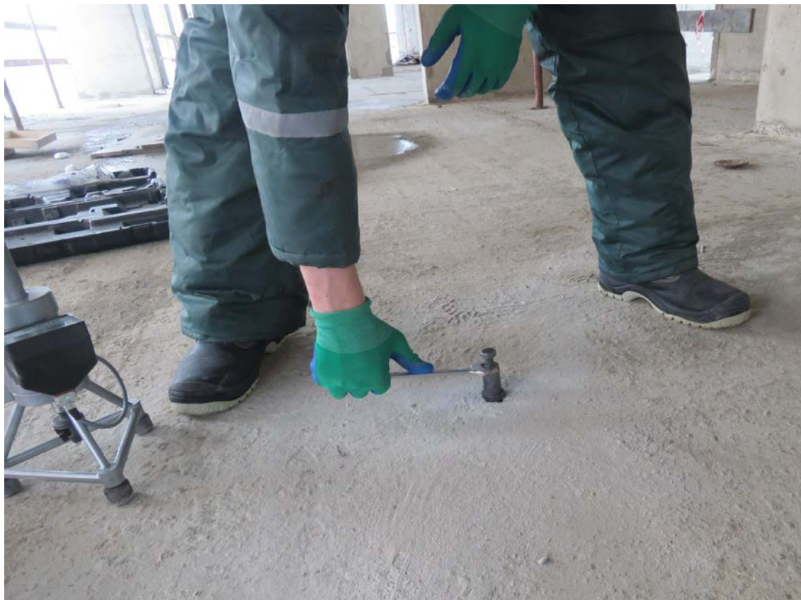
Рис. 4.2.11. Установка анкерного устройства и тяги в отверстии монолитной железобетонной плиты перекрытия третьего этажа в осях 12/1-14/1/А/1-Б/1
