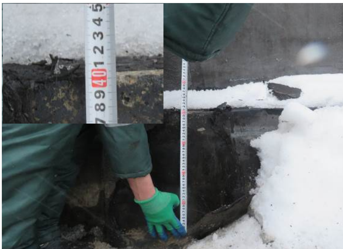
Рис. 3.1.6. Замер толщины фундаментной плиты в осях 2/2-3/2/А/2
