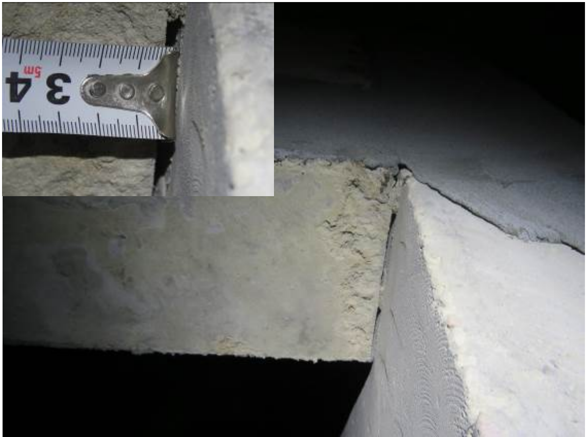
Рис. 3.3.20. Участок отсутствия сопряжения монолитной балки с пилоном в осях 2/1/А
