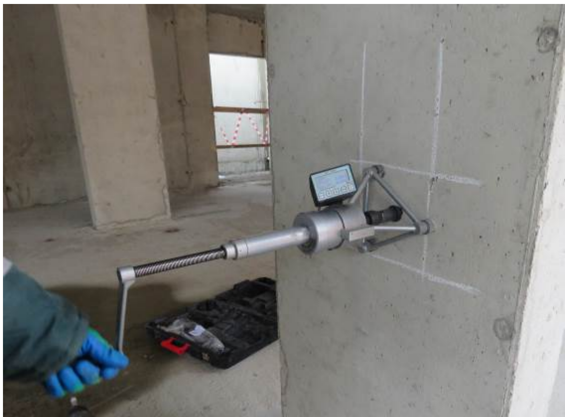
Рис. 4.2.8. Испытание бетона монолитного железобетонного пилона подвального этажа в осях 12/1/А/1-Б/1 методом отрыва со скалыванием прибором «ПОС 50МГ-4»
