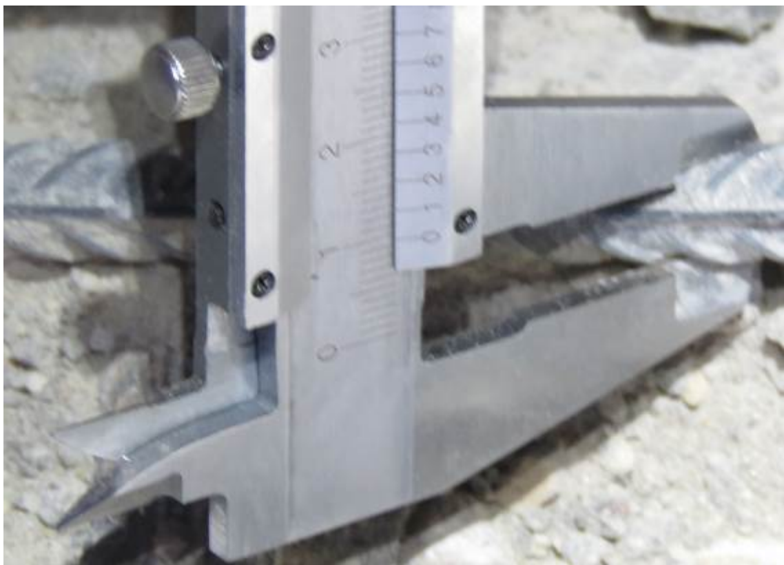
Рис. 3.3.10. Замер диаметра верхнего армирования плиты перекрытия второго этажа в осях 17/Г/Г/1-Д/1
