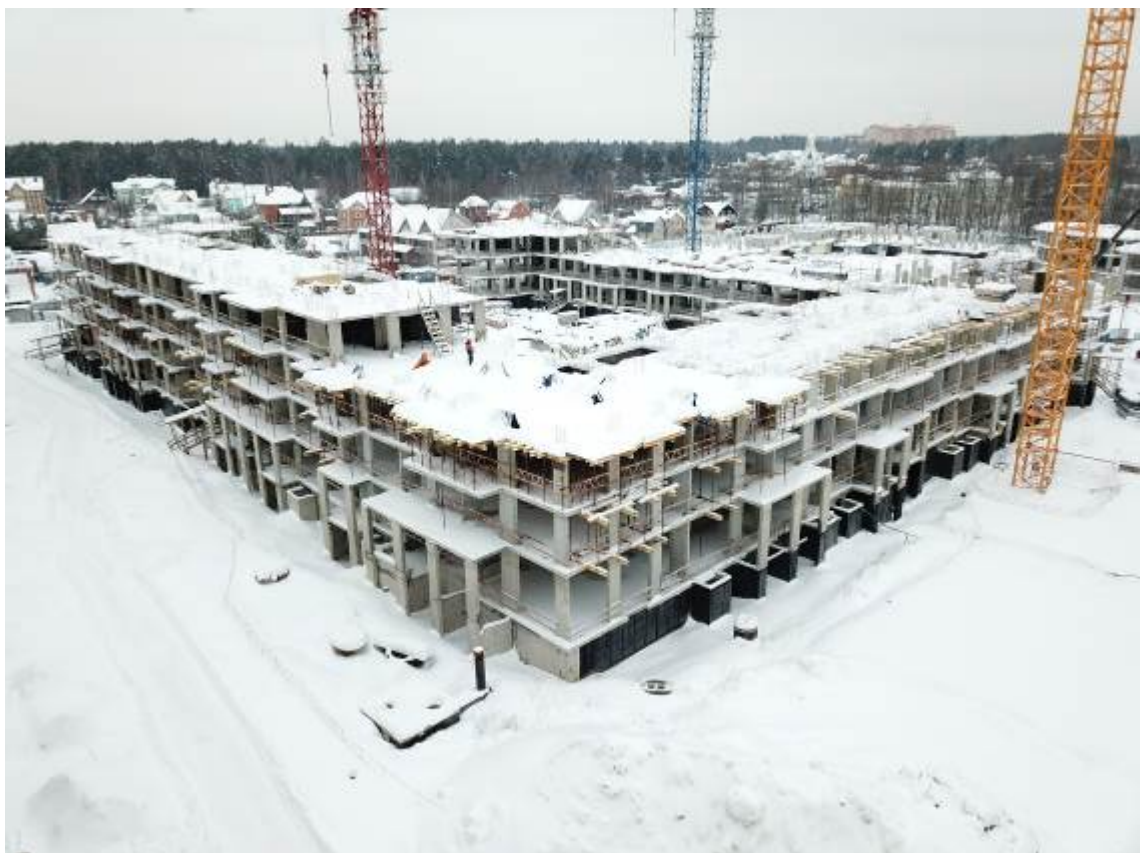
Рис. 1.4. Общий вид обследуемого здания с юго-востока
