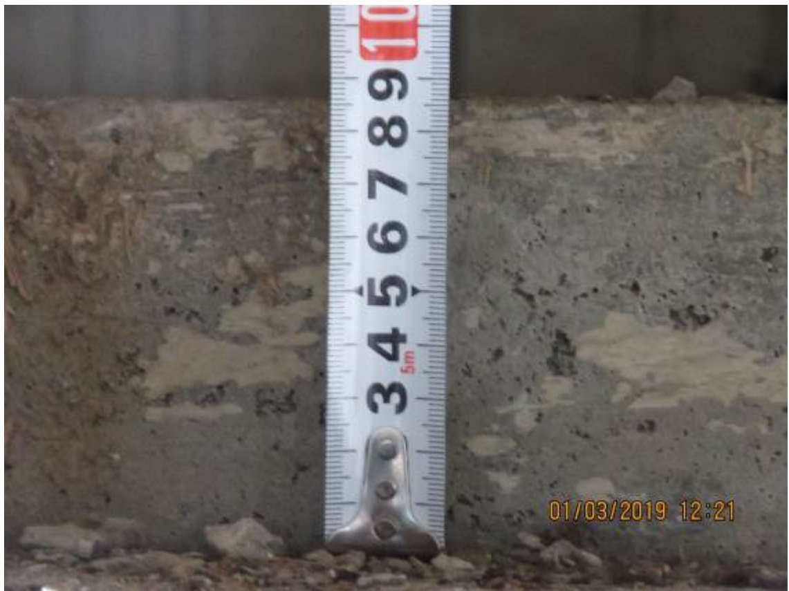
Рис.3.5.5. (а, б) Замер высоты сечений межэтажной монолитной лестничной площадки в узле опирания лестничных маршей
