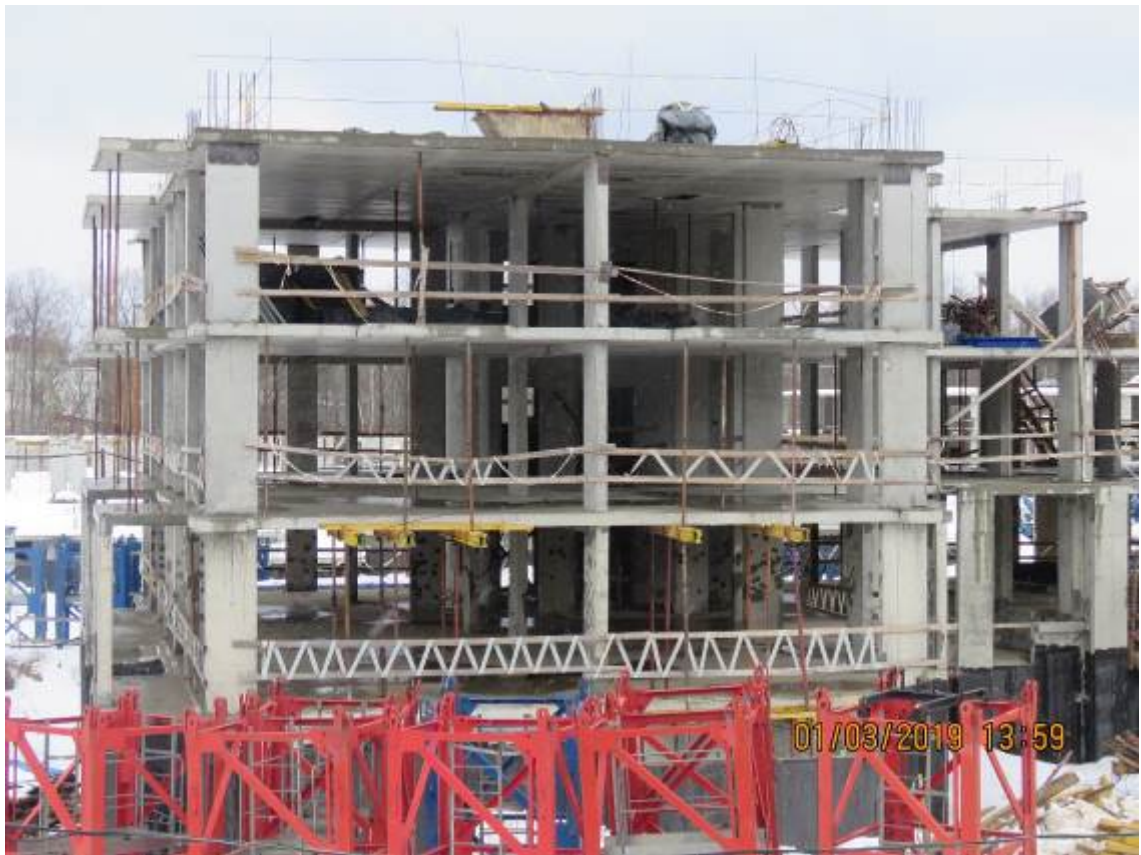
Рис. 3.2.2. Общий вид смонтированных конструкций секции № 10
