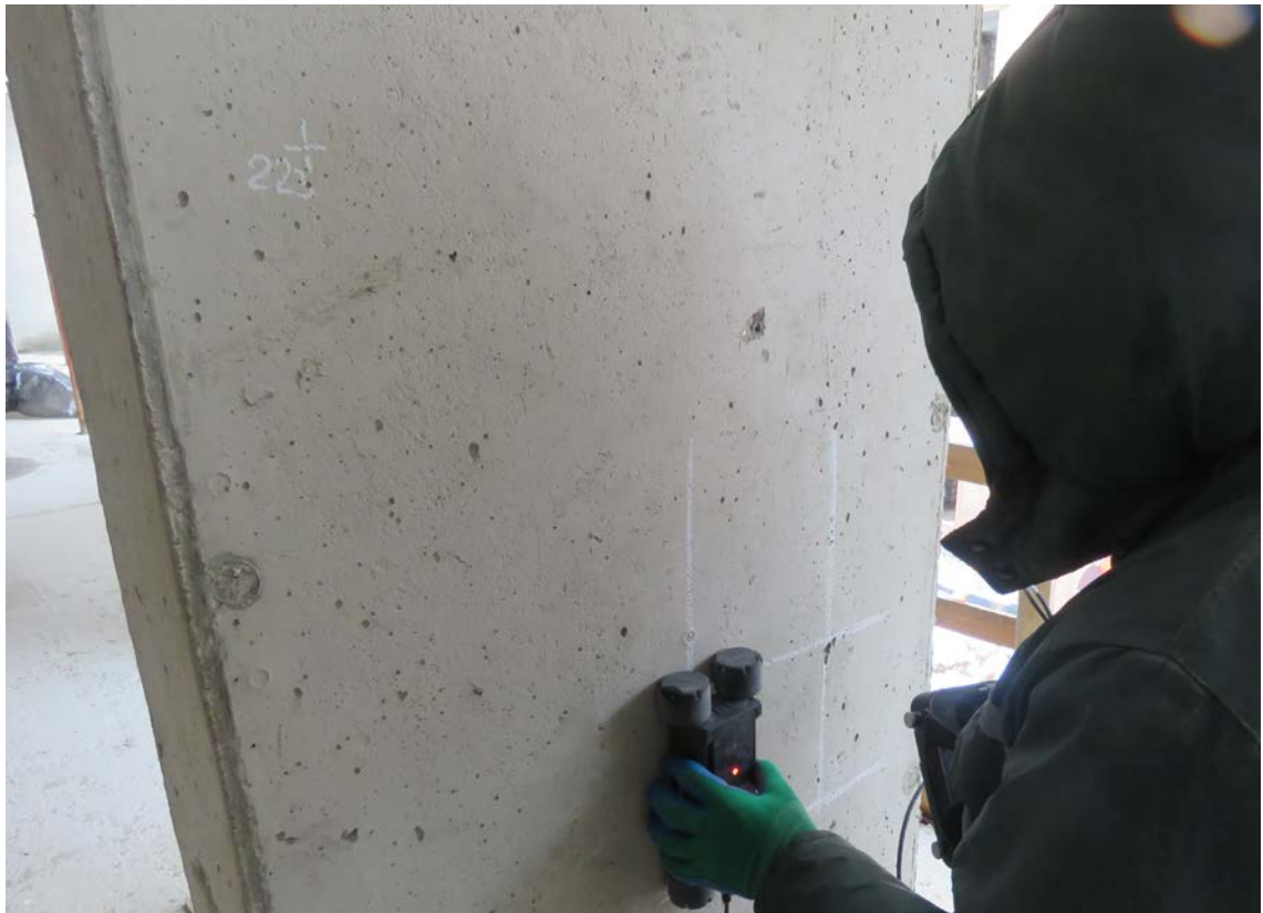
Рис. 4.4.1. Замеры шага арматуры, определение величины защитного слоя бетона в монолитном пилоне магнитным методом прибором «Profometer PM-6»
