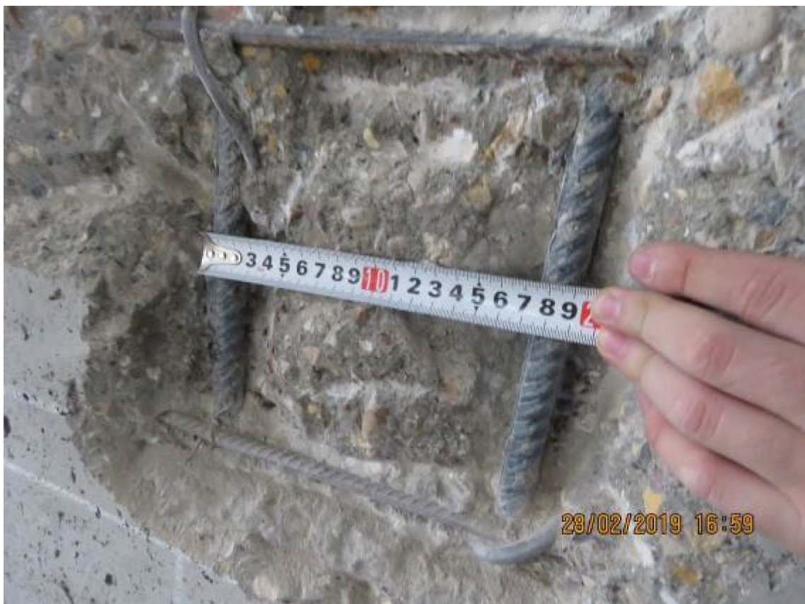
Рис. 3.2.6. Замер шага арматуры в монолитном пилоне первого этажа в осях 29/2-30/2/Г/4
