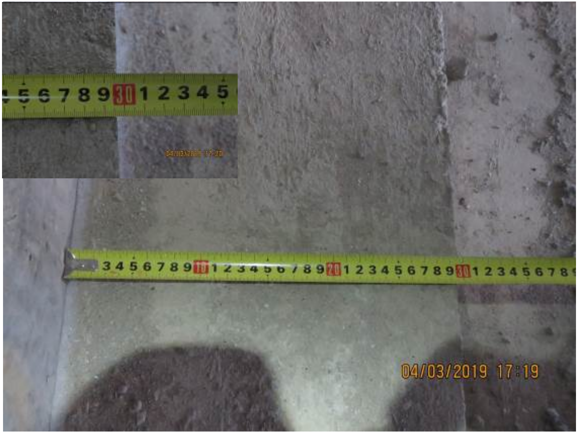
Рис.3.5.6. Замер проступи монолитного лестничного марша тамбура
