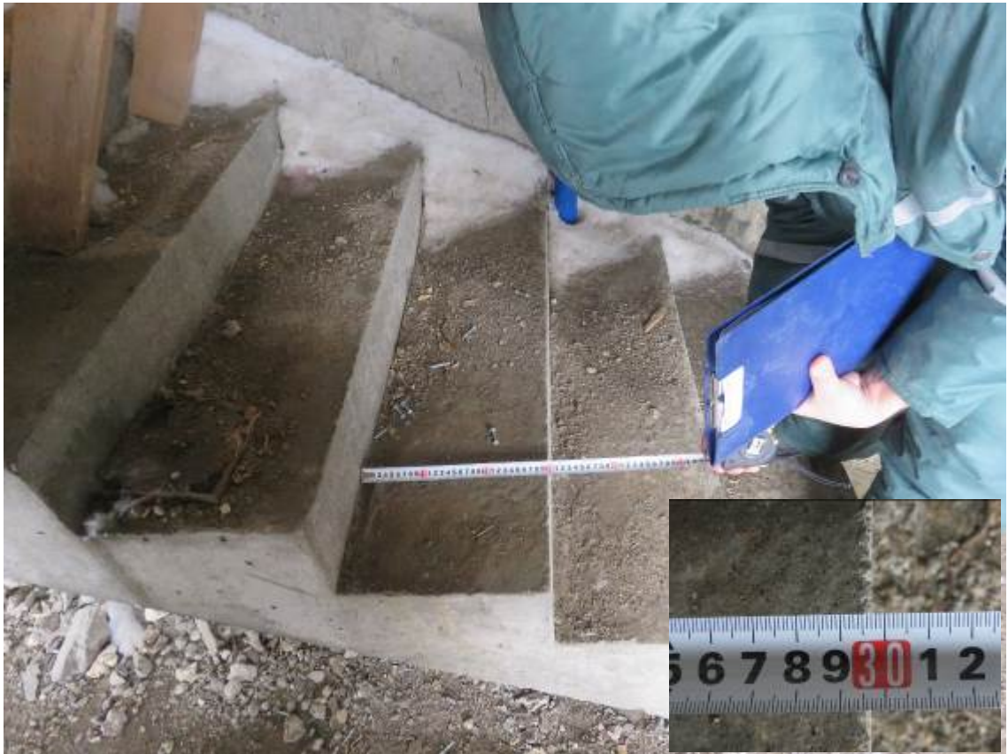
Рис.3.5.3. Замер проступи монолитного междуэтажного лестничного марша
