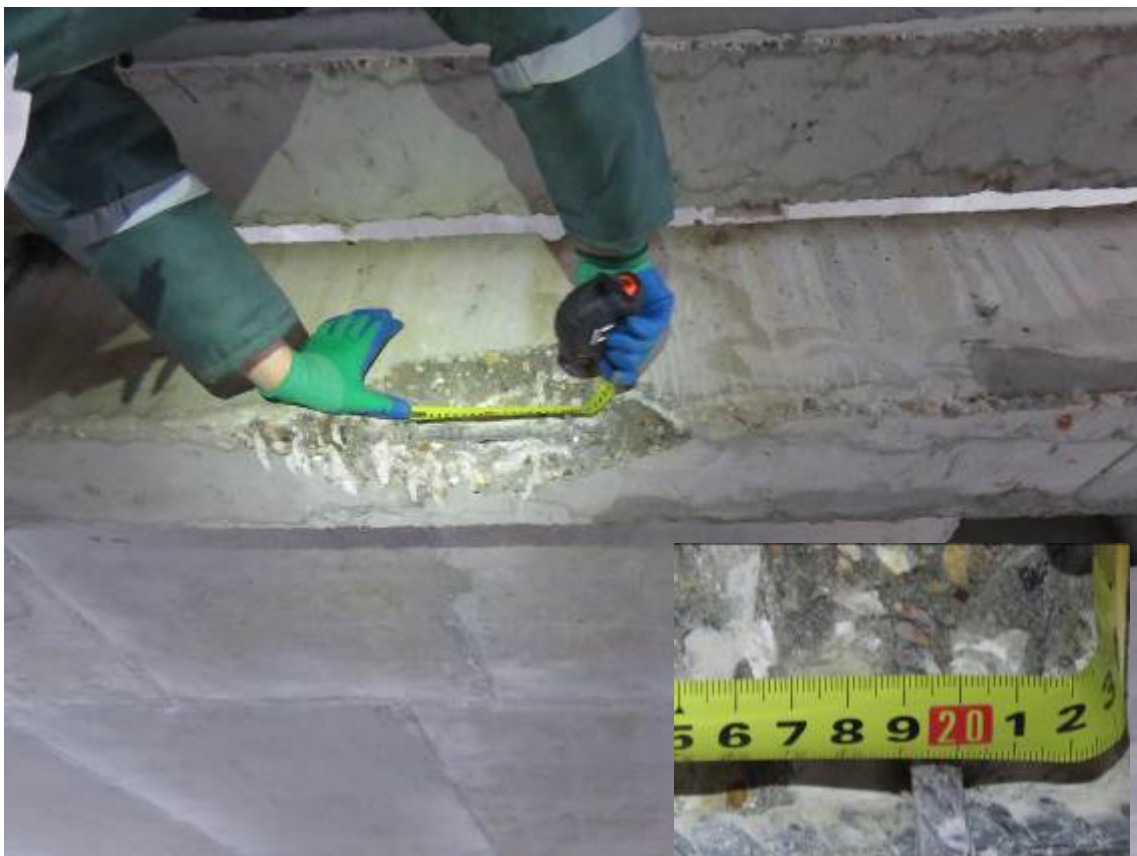
Рис. 3.3.14. Замер шага поперечных арматурных стержней монолитной балки в осях 29/2-30/2/Ш/3
