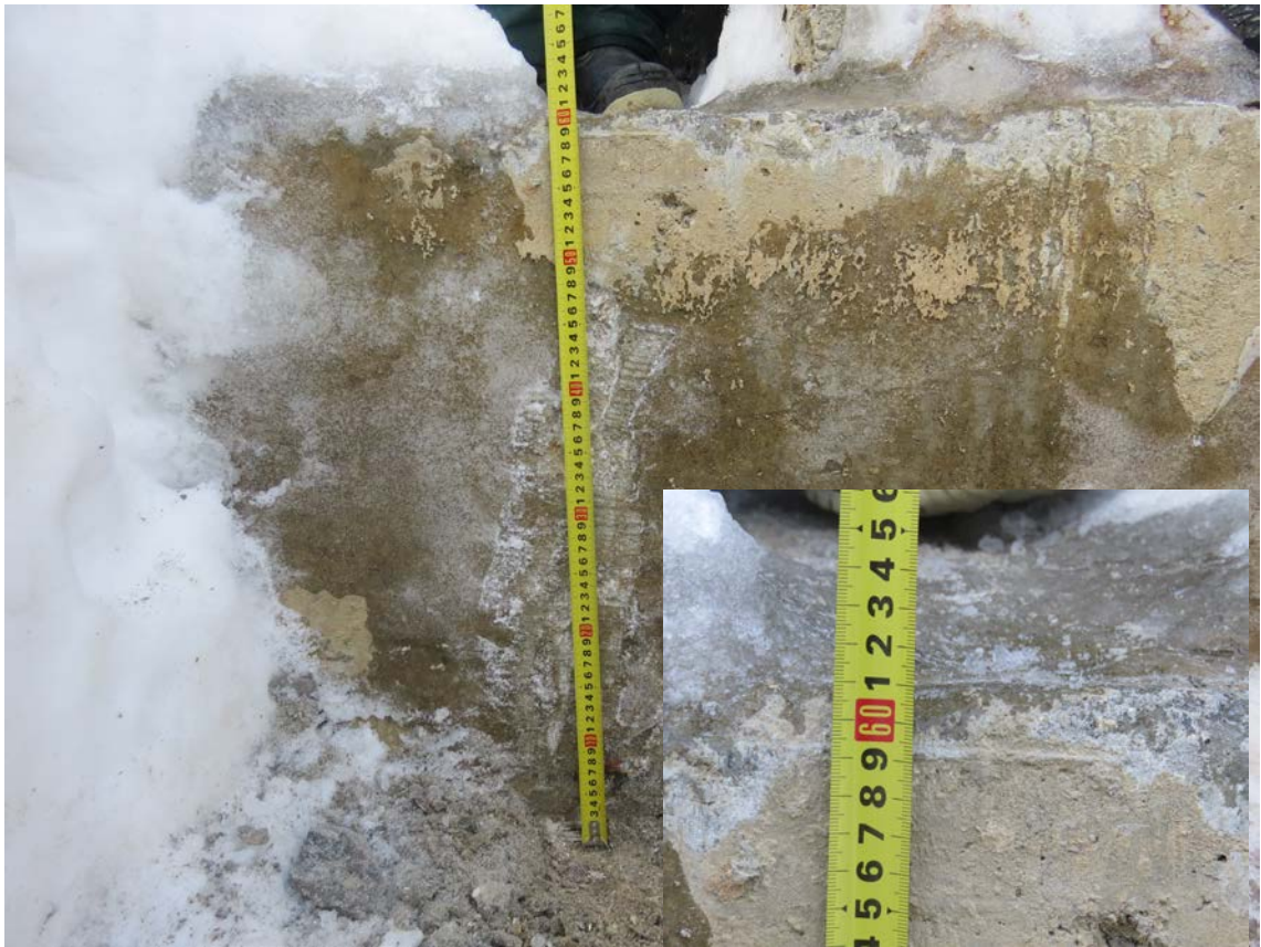
Рис. 3.1.3. Замер толщины фундаментной плиты в осях 29/2-30/2/П/2
