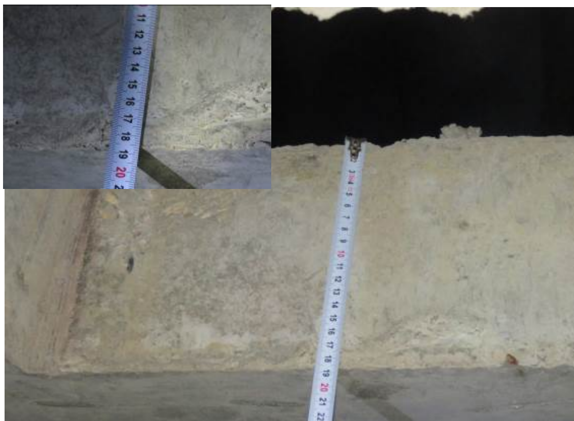
Рис. 2.4. Замер высоты сечения монолитной плиты перекрытия подвального этажа (187 мм)
