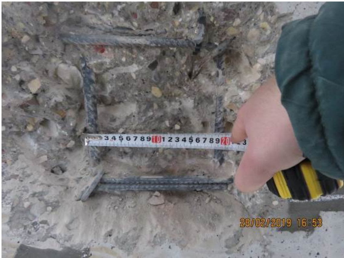
Рис. 3.2.3. Замер шага арматуры в монолитном пилоне первого этажа в осях 11/2/Н/2
