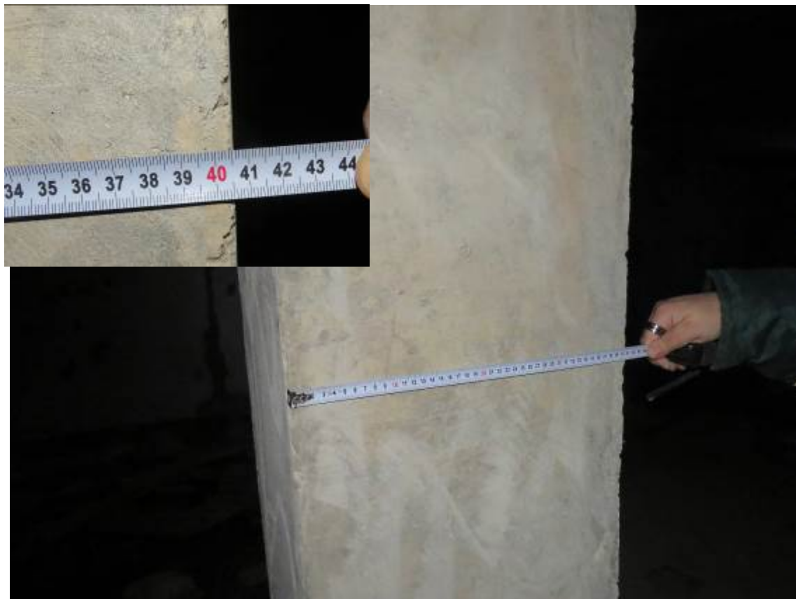
Рис. 2.3. Замер сечение монолитного железобетонного пилона подвального этажа (400×200 мм)
