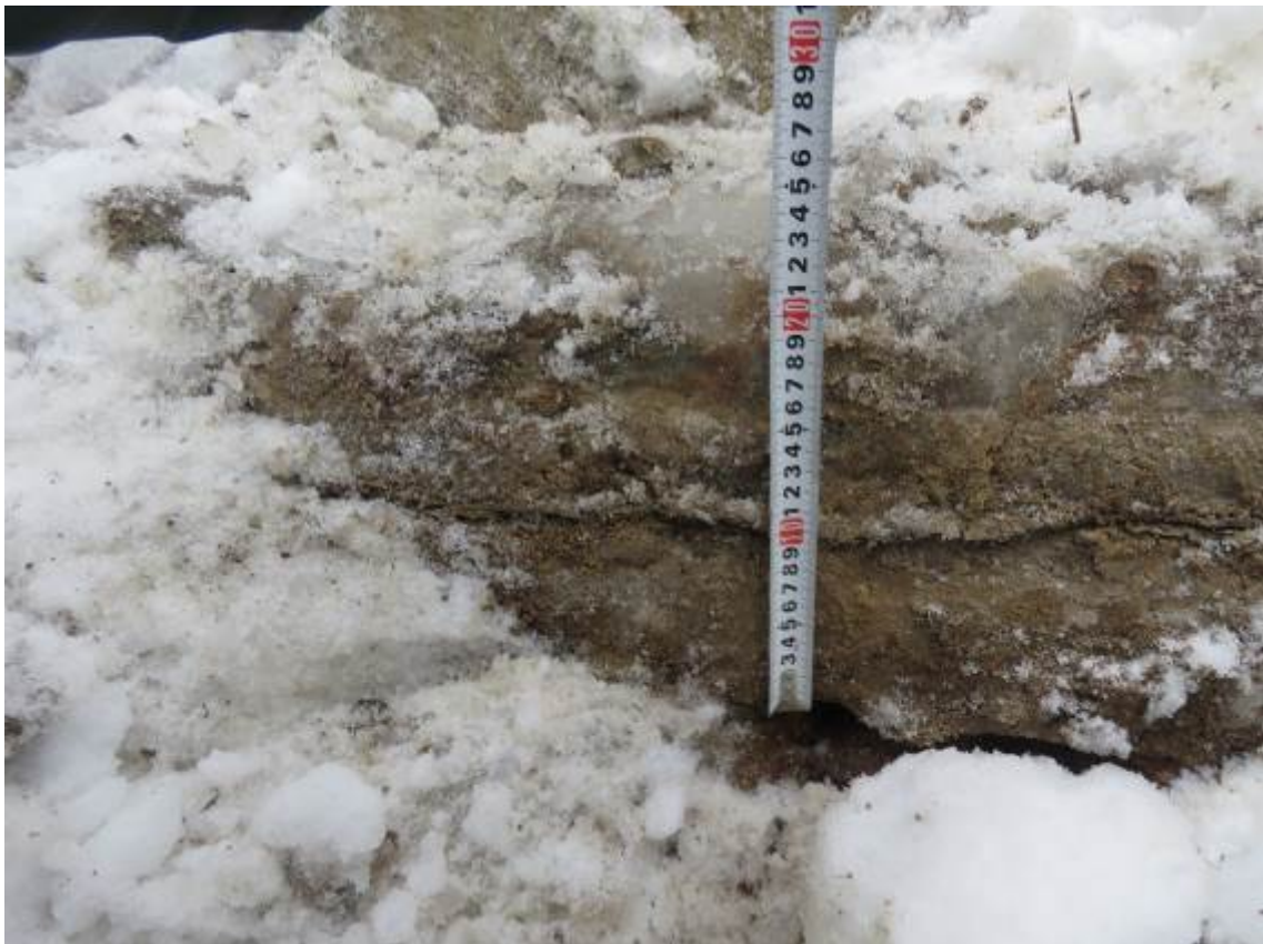
Рис. 3.1.2. Замер толщины бетонной подготовки под фундаментной плитой в осях 29/2-30/2/П/2
