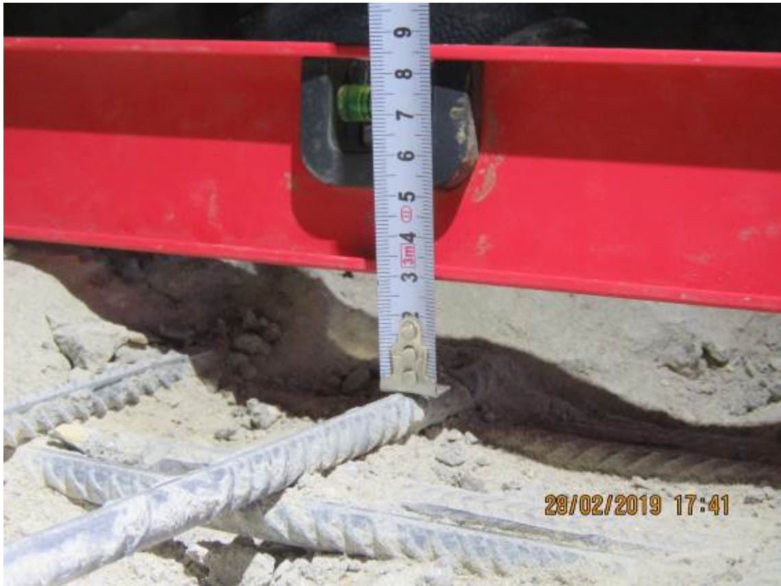
Рис. 3.3.11. Замер защитной слоя бетона плиты перекрытия второго этажа в осях 17/Г/Г/1-Д/1
