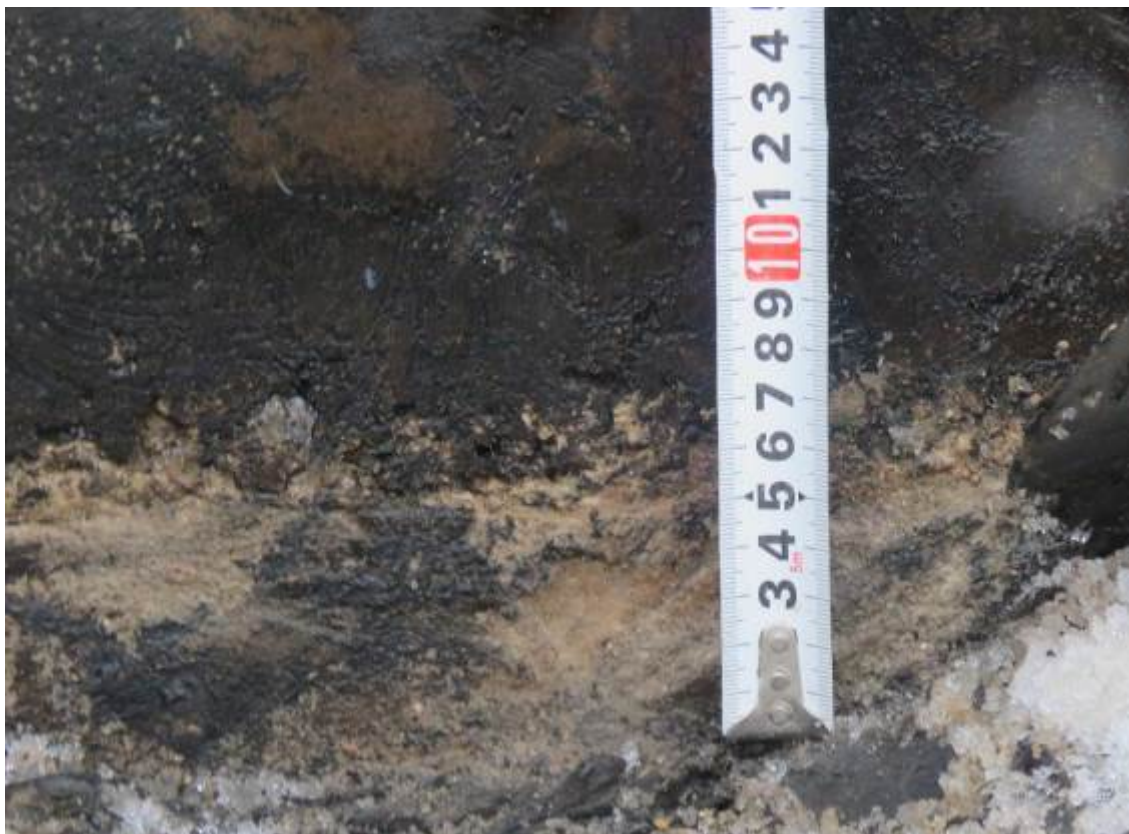
Рис. 3.1.5. Замер толщины защитной цементно-песчаной стяжки в осях 2/2-3/2/А/2
