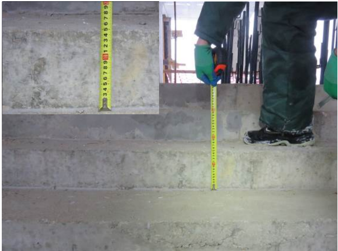
Рис.3.5.7. Замер подступенка монолитного лестничного марша тамбура
