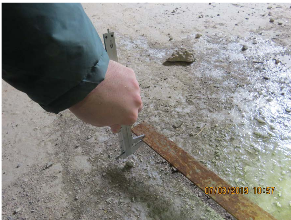
Рис. 3.7.2 (а, б). Замер сечения выпусков заземления. Коррозия стальных пластин
