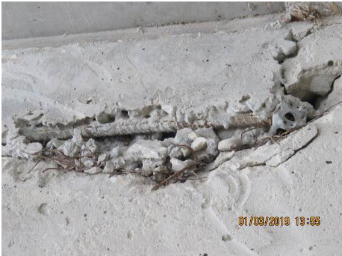
Рис.3.3.21 (а, б, в, г). Нарушение технологии бетонирования (раковины, косослой), механических повреждения с оголением и коррозией арматуры в участке сопряжения монолитных балок и пилонов
