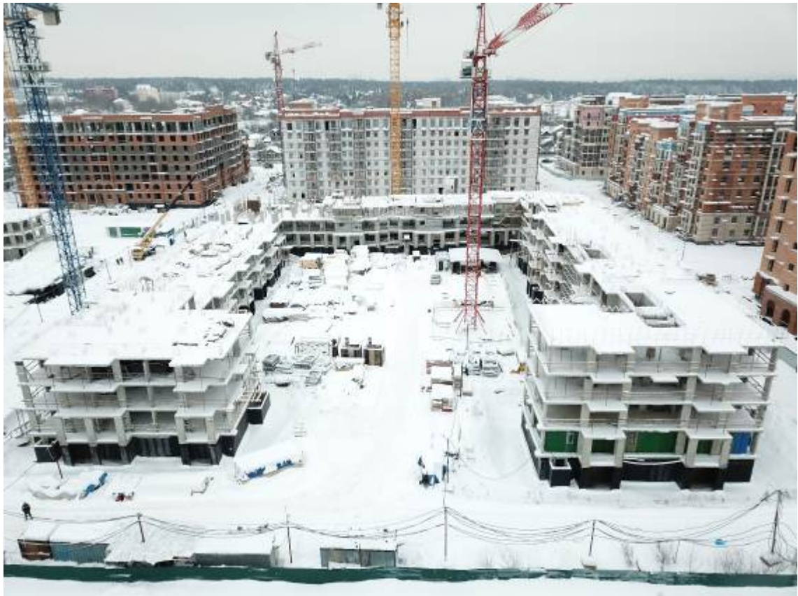
Рис. 1.3. Общий вид обследуемого здания с запада
