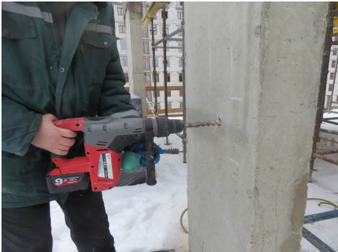
Рис. 4.2.1. Сверление отверстия в монолитном железобетонном пилоне третьего этажа в осях 29/2-30/2/В/4
