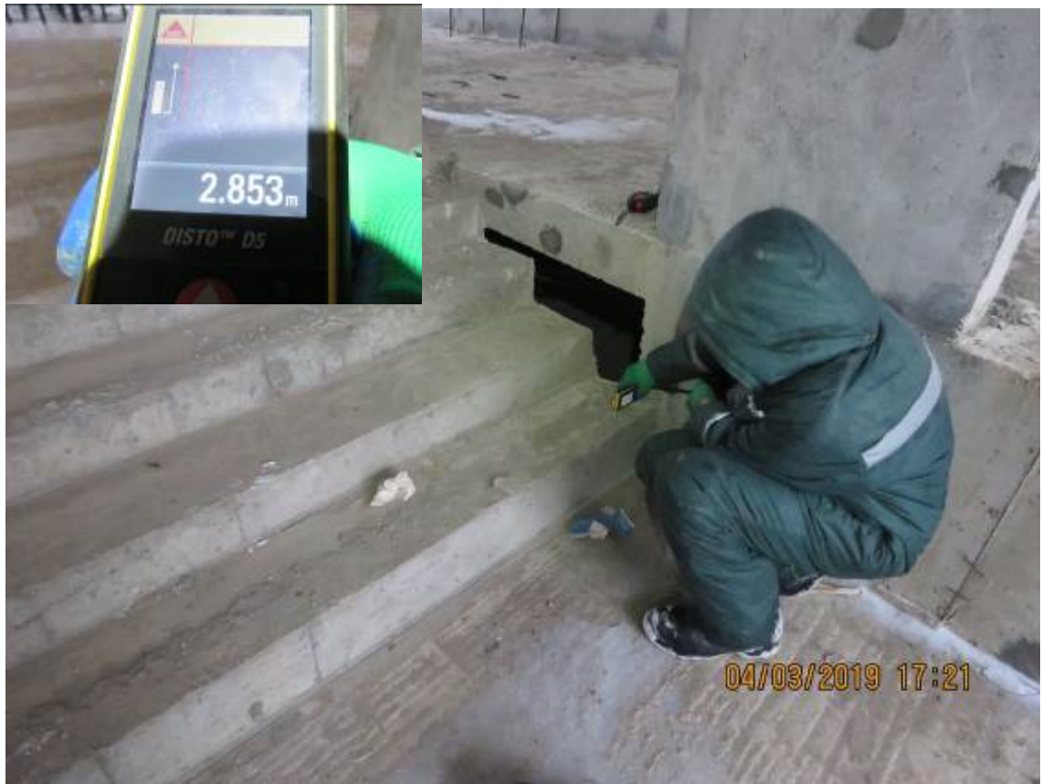
Рис.3.5.8. Замер ширины монолитного лестничного марша тамбура
