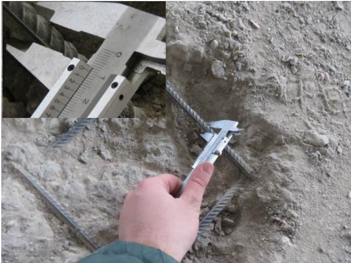
Рис. 3.3.3. Замер диаметра верхнего армирования плиты перекрытия подвального этажа в осях 29/2-30/2/А/5-Б/5
