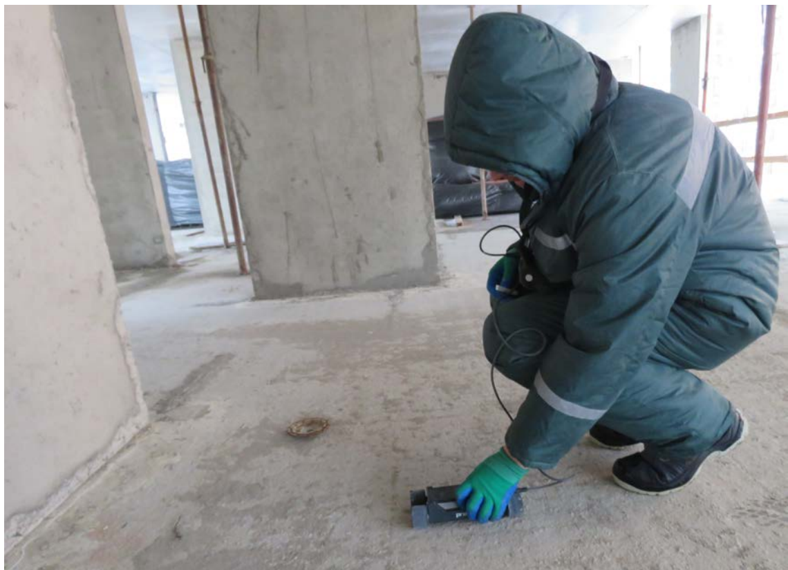
Рис. 4.4.2. Замеры шага арматуры, определение величины защитного слоя бетона в монолитной железобетонной плите перекрытия магнитным методом прибором «Profometer PM-6»
