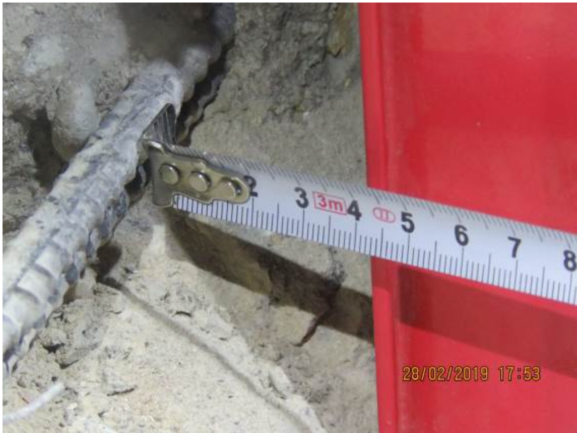
Рис.3.2.19. Замер защитного слоя бетона монолитной стены подвального этажа в осях 2/2/Б/2-В/2
