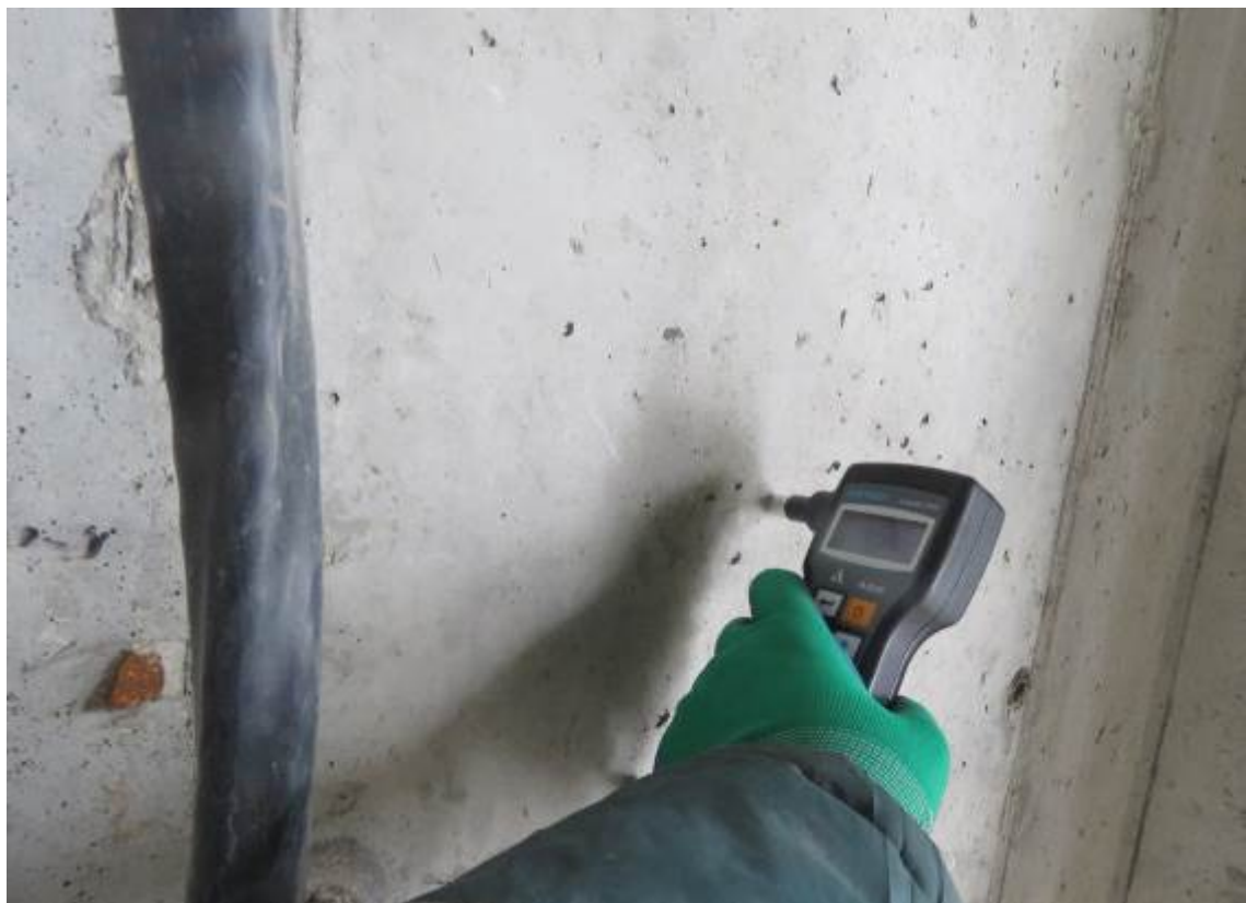
Рис. 4.3.3. Определение скорости ультразвука в монолитной железобетонной стене первого этажа ультразвуковым методом прибором «UK 1401»
