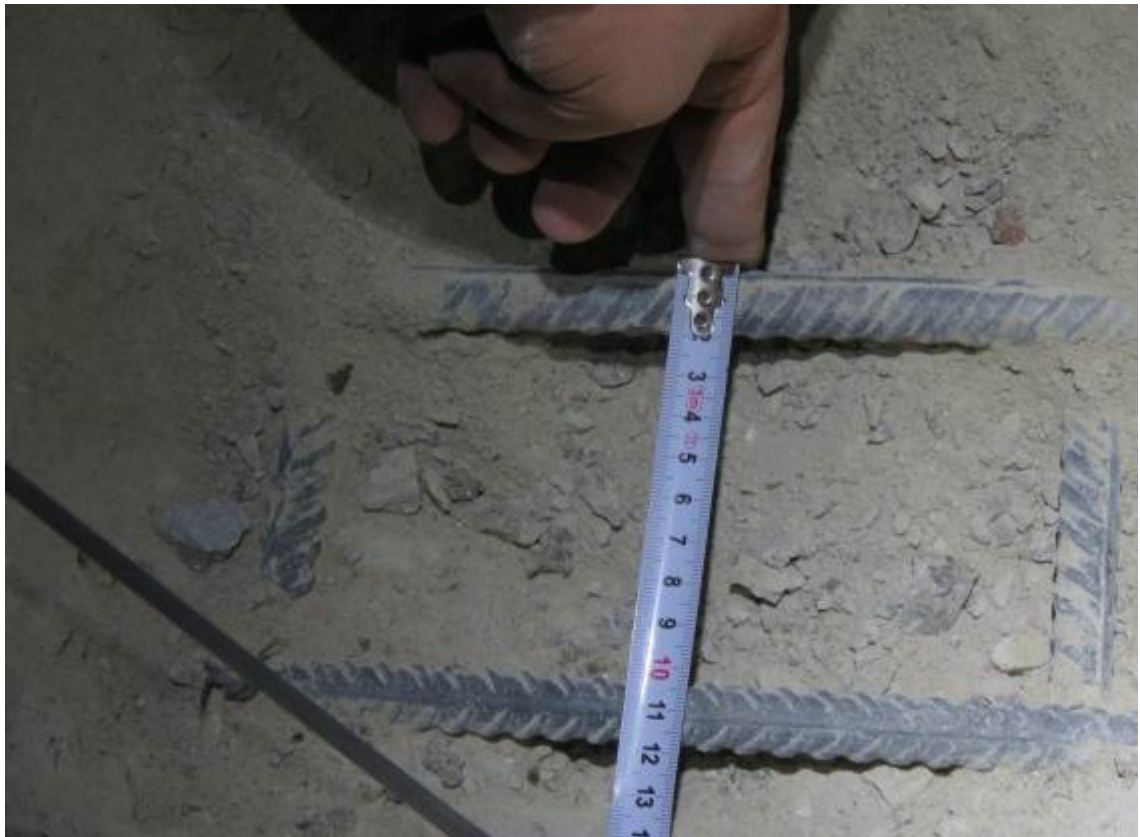
Рис. 3.1.10. Замер шага верхнего армирования фундаментной плиты в осях 2/2-3/2/Б/2-В/2
