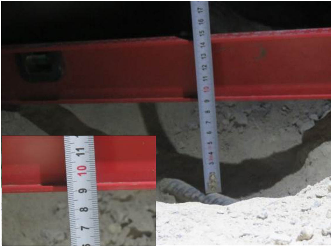
Рис. 3.1.12. Замер защитного слоя бетона фундаментной плиты в осях 2/2-3/2/Б/2-В/2
