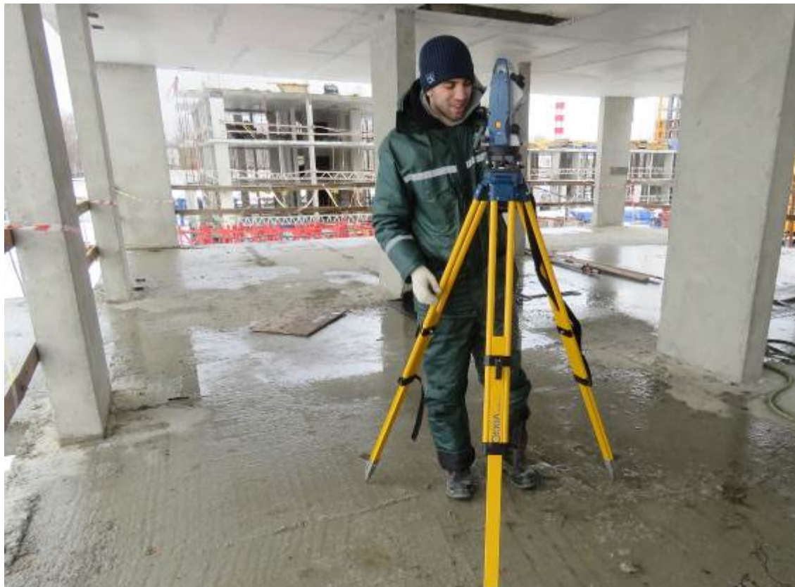
Рис. 2.9. Определение планового положения пилонов четвёртого этажа электронным тахеометром Sokkia CX-105
