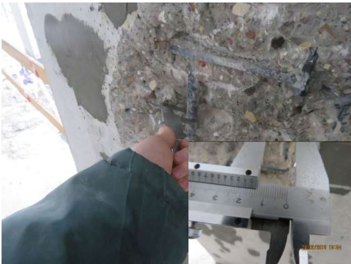
Рис. 3.2.4. Замер диаметра арматурного стержня в монолитном пилоне первого этажа в осях 11/2/Н/2
