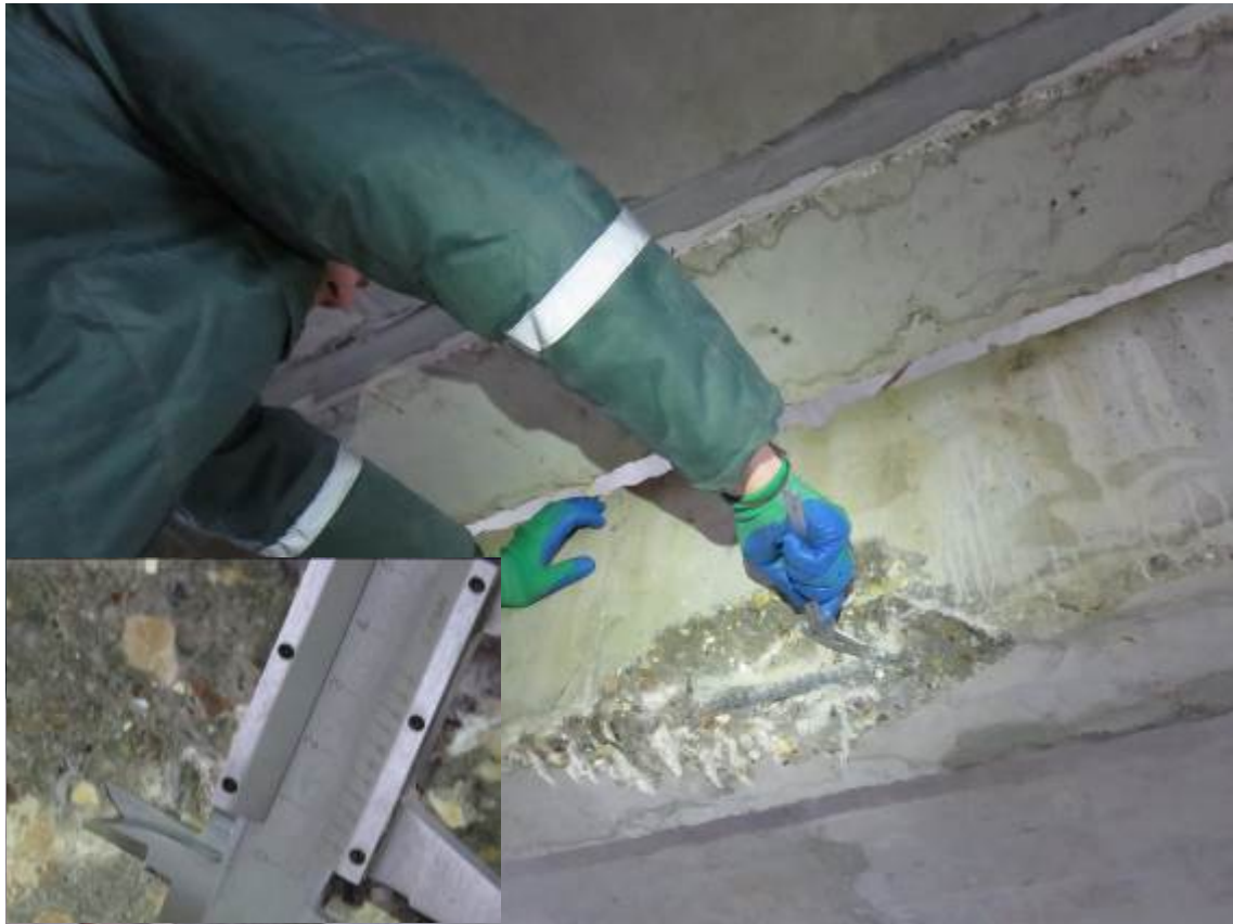
Рис. 3.3.13. Замер диаметра поперечного арматурного стержня монолитной балки в осях 29/2-30/2/Ш/3
