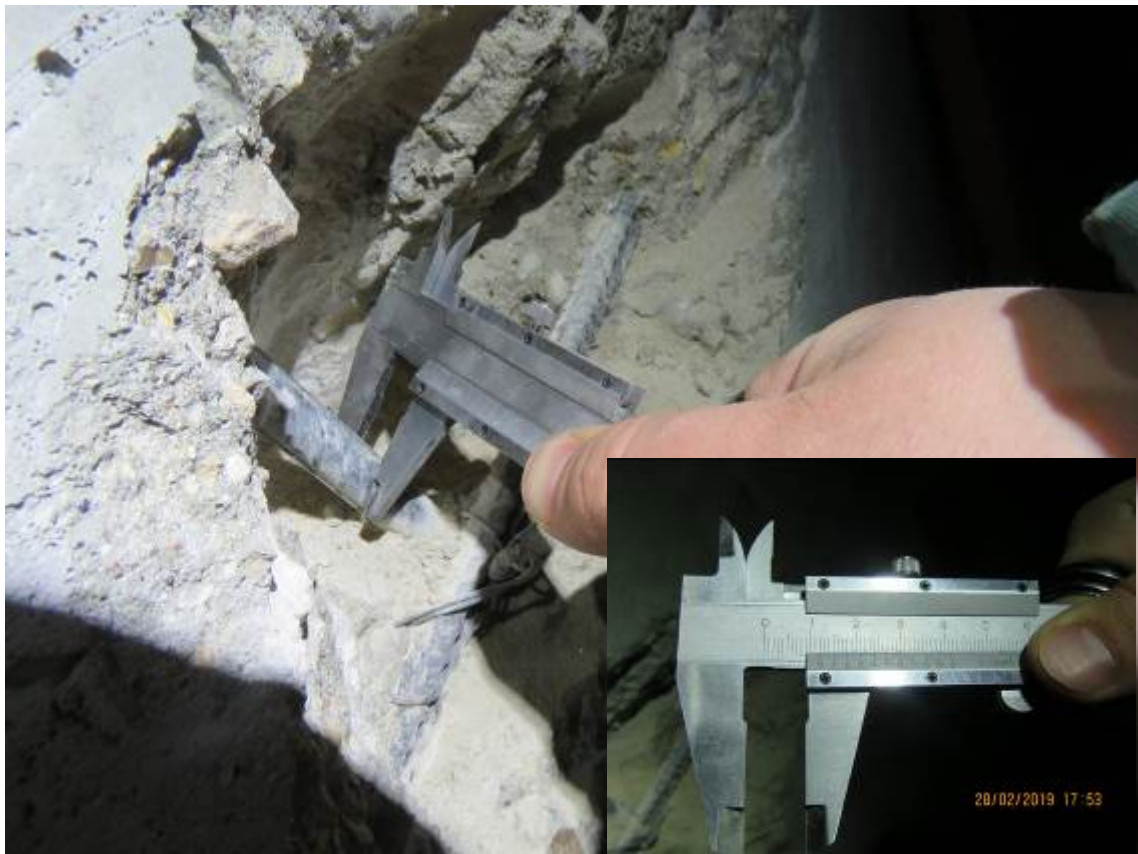
Рис. 3.2.17. Замер диаметра вертикального арматурного стержня в монолитной стене подвального этажа в осях 2/2/Б/2-В/2
