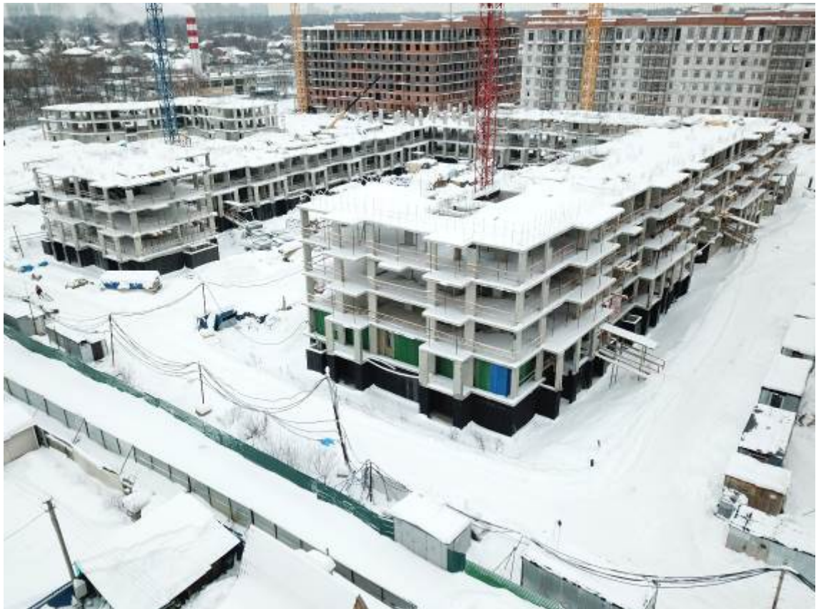
Рис.3.6.1. Общий вид смонтированных конструкций здания. Отсутствие конструкций покрытия и кровли
