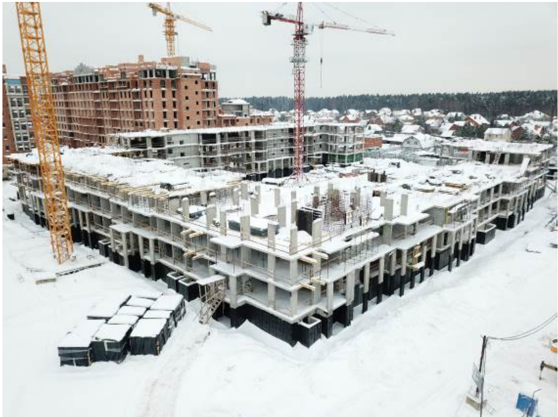
Рис. 1.1. Общий вид обследуемого здания с северо-востока
