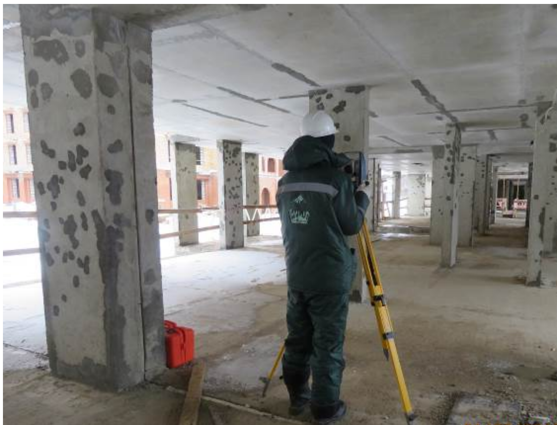
Рис. 2.10. Определение высотного положения нижней плоскости плиты перекрытия первого этажа электронным тахеометром Sokkia CX-105
