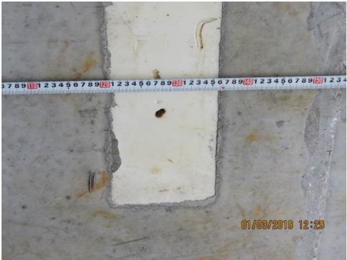
Рис.3.3.15 (а, б). Замер геометрических параметров термокладышей
