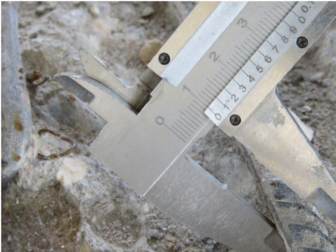
Рис. 3.3.5. Замер диаметра фонового верхнего армирования плиты перекрытия второго этажа в осях 15/1-16/1/А/1
