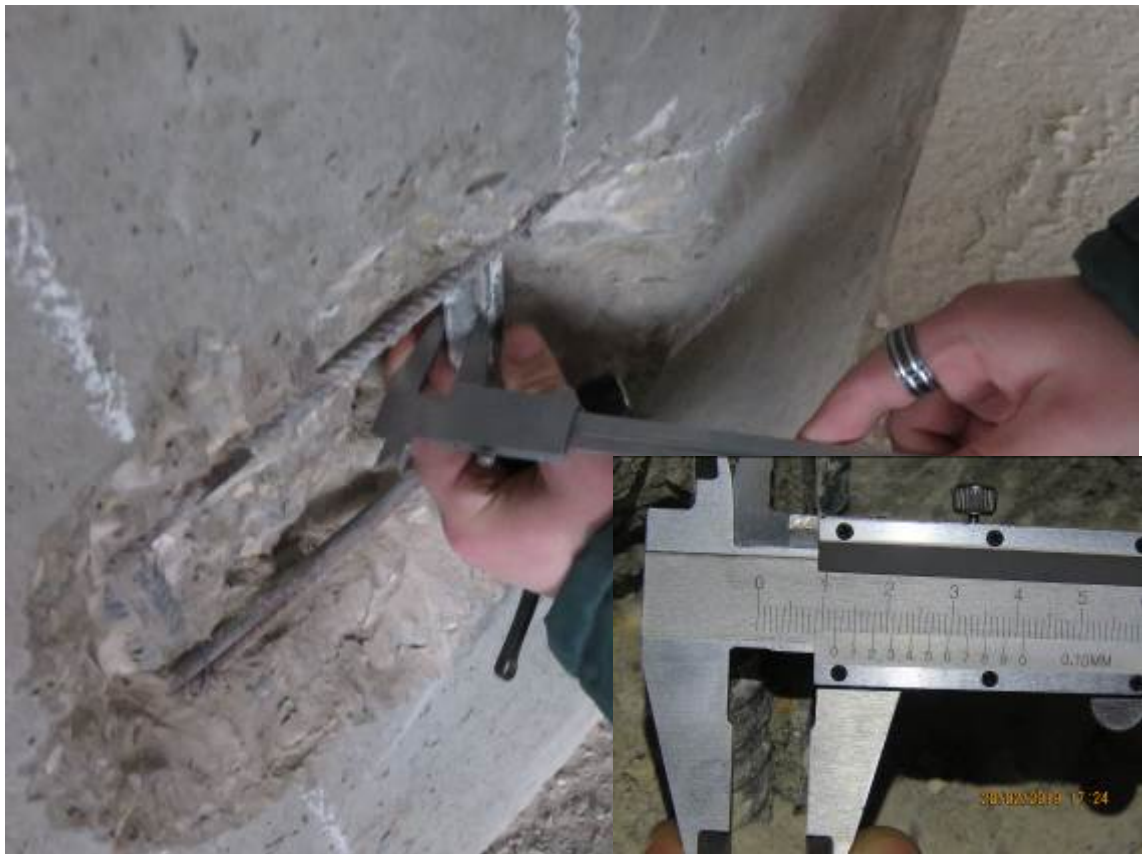
Рис. 3.2.9. Замер диаметра вертикального арматурного стержня в монолитном пилоне третьего этажа в осях 3/1/Б/1
