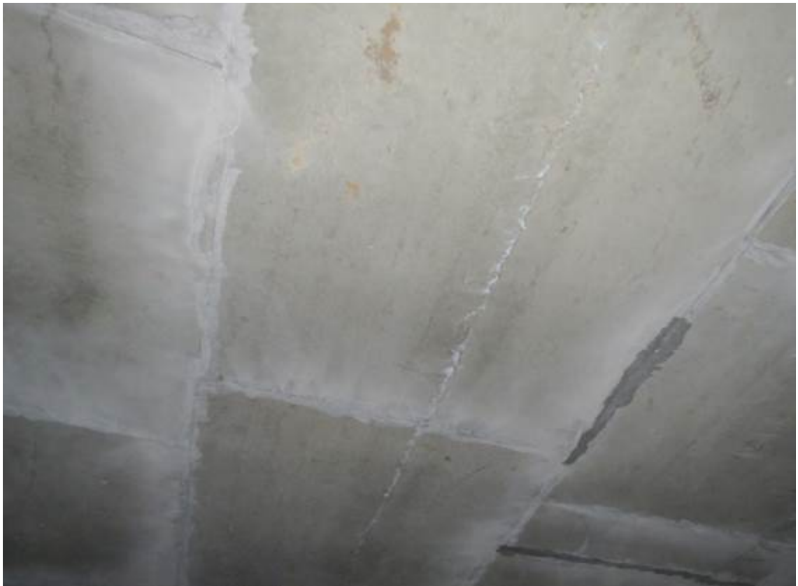
Рис. 3.3.16 (а, б). Трещины по нижней плоскости плит перекрытий
