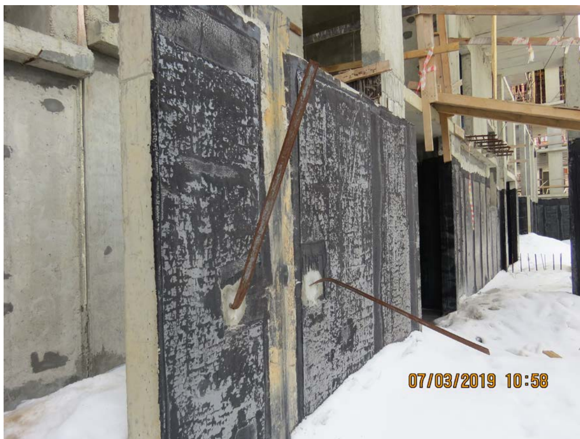
Рис. 3.7.1. Общий вид выпусков заземления
