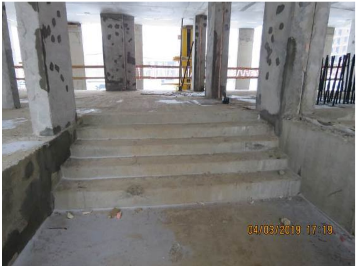
Рис.3.5.2. Общий вид конструкций лестниц тамбура секции № 8
