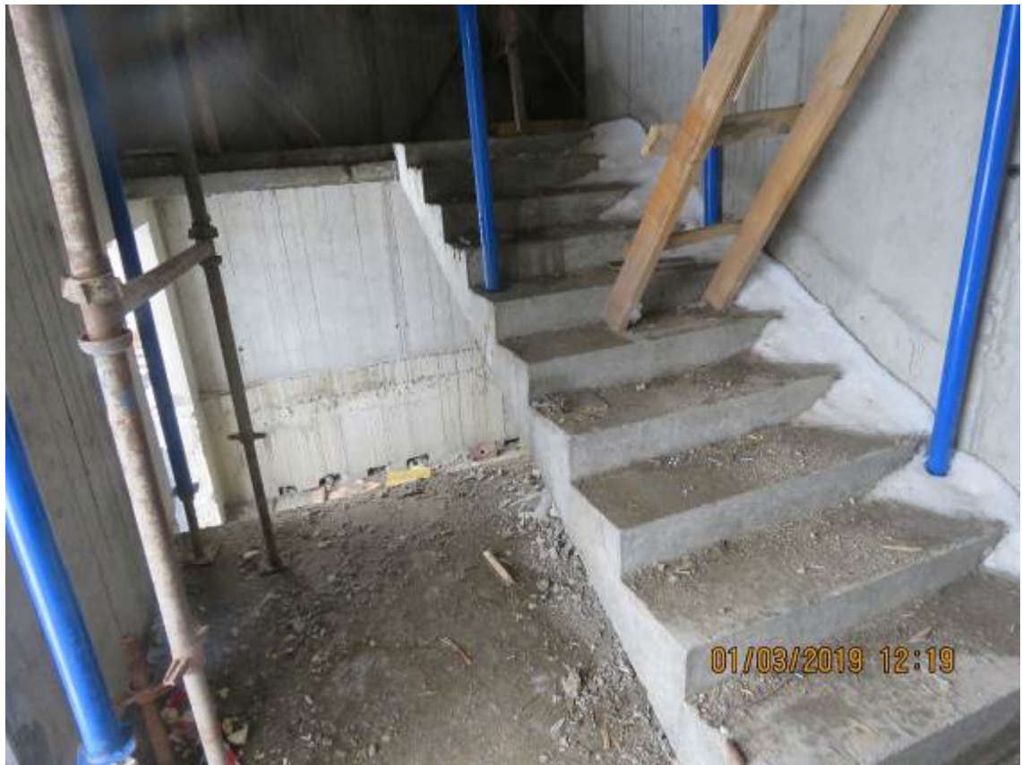
Рис.3.5.1. Общий вид конструкций междуэтажных лестниц секции № 10
