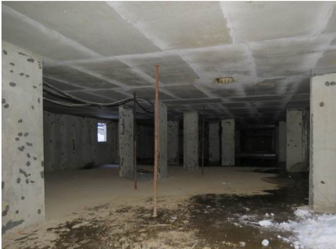
Рис. 3.1.1. Общий вид подвального этажа в осях 14/2-17/2/Г/2-Н/2
