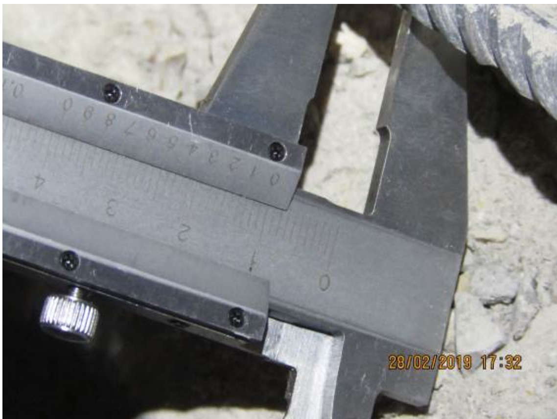
Рис. 3.2.16. Замер диаметра горизонтального стержня в монолитной стене третьего этажа в осях 12/1-13/1/Г/1
