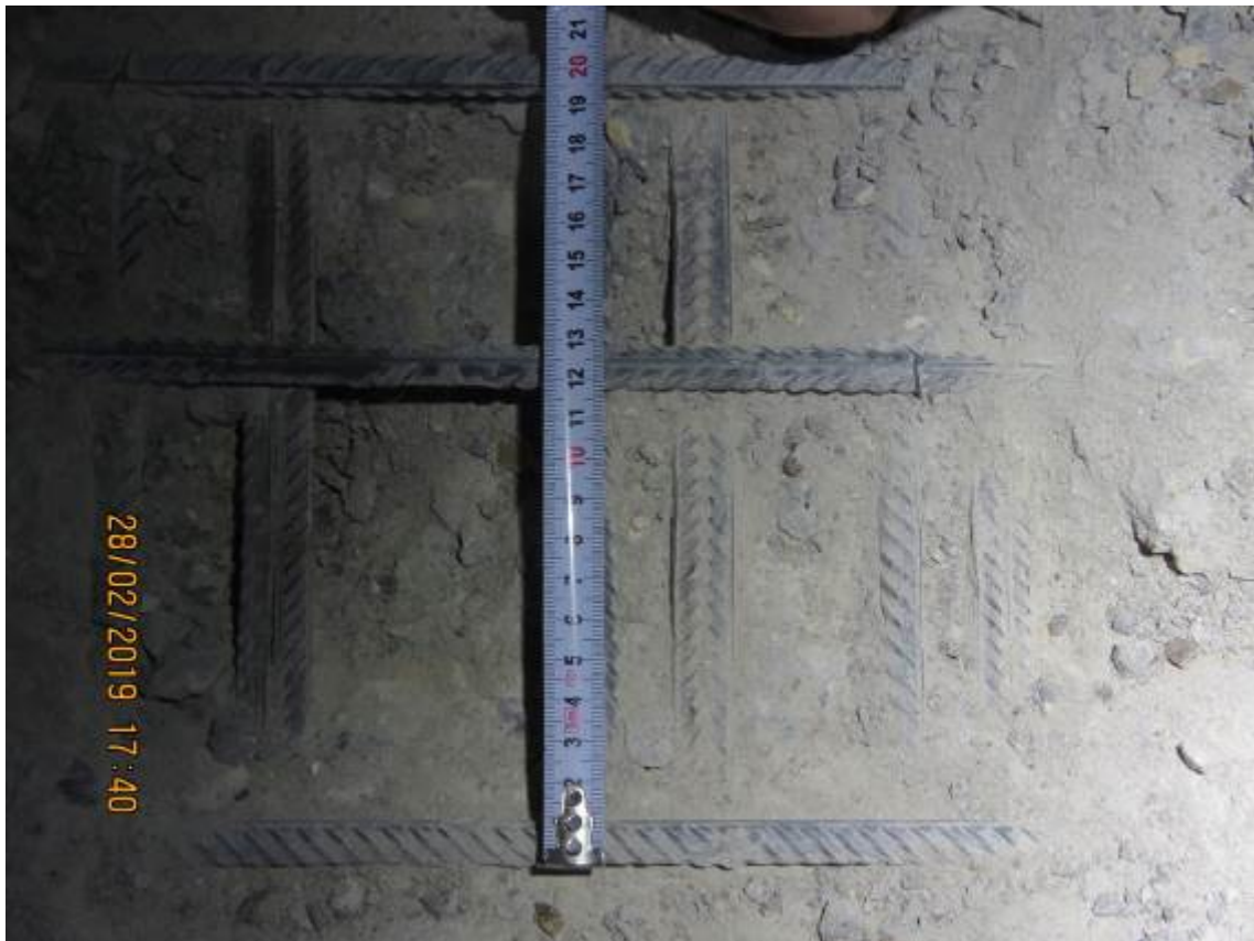
Рис. 3.3.9. Замер шага верхнего армирования плиты перекрытия второго этажа в осях 17/Г/Г/1-Д/1
