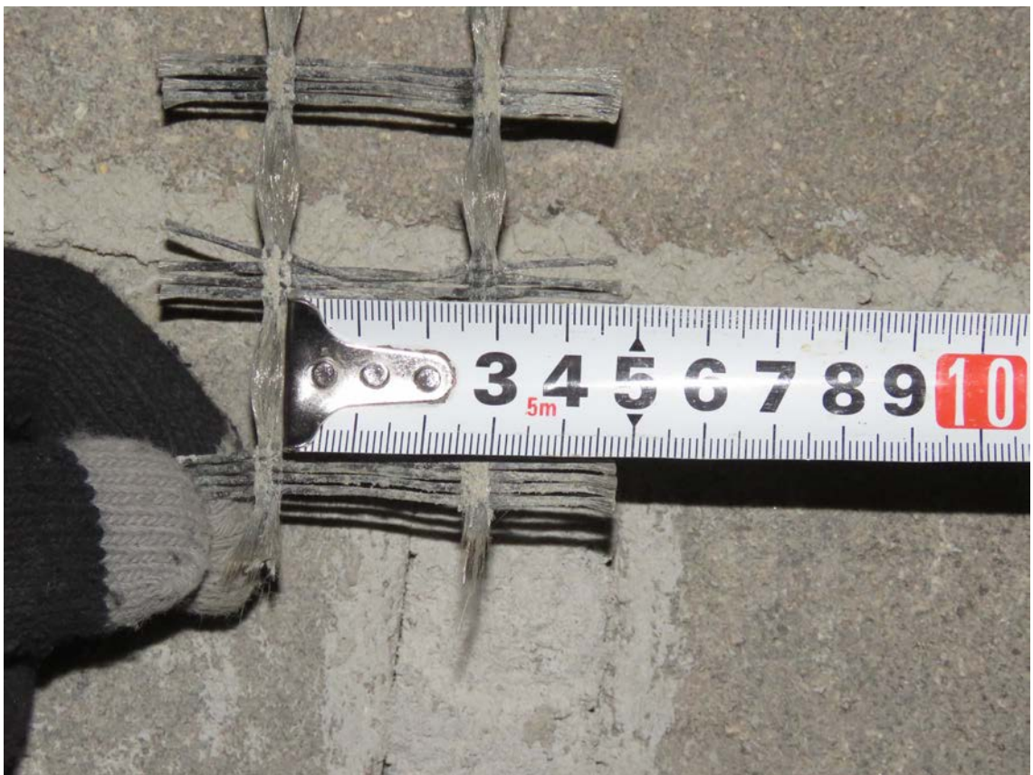
Рис.3.4.2. Замер ячейки базальтовой сетки
