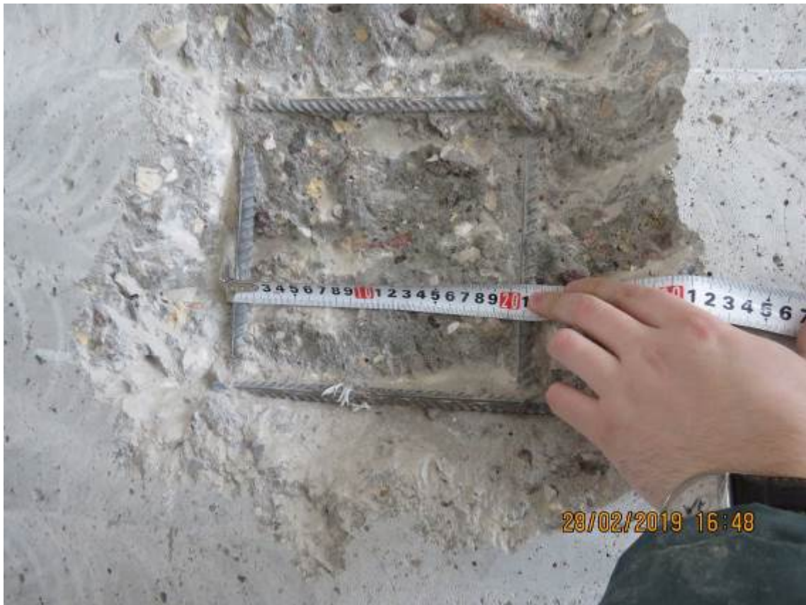
Рис. 3.2.13. Замер шага вертикальных арматурных стержней в монолитной стене первого этажа в осях 7/2/Л/2-М/2
