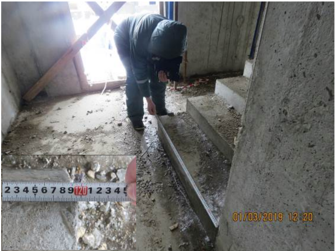
Рис.3.5.4. Замер ширины монолитного междуэтажного лестничного марша
